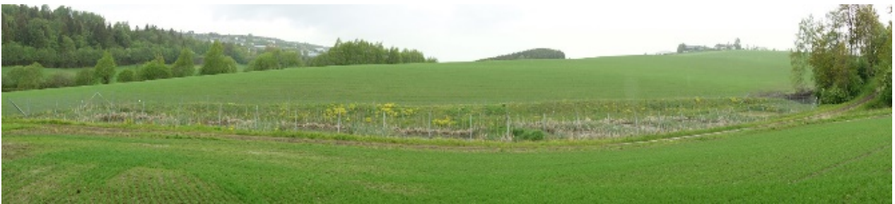
Fangdam for sigevann fra fylling. Deler av åker drenerer også inn i fangdam.
