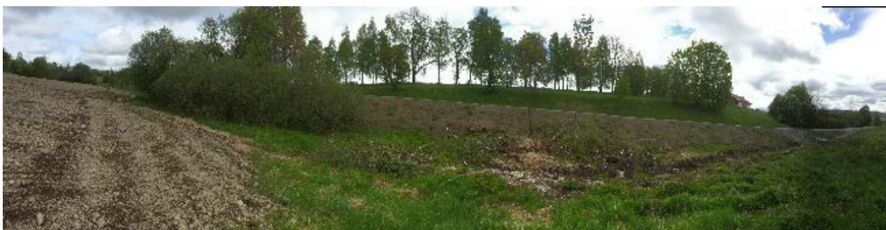
Kulvert under veien. Bekk langs jordekant
