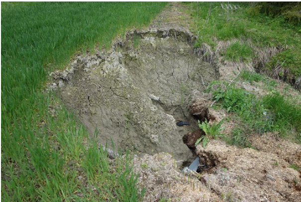
Rasområdet i skrent før innløpet av aktuell fangdam, vår 2015
