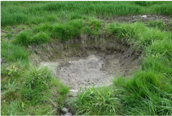
Brudd i drenering ved innløp av eventuell fangdam, vår 2015
