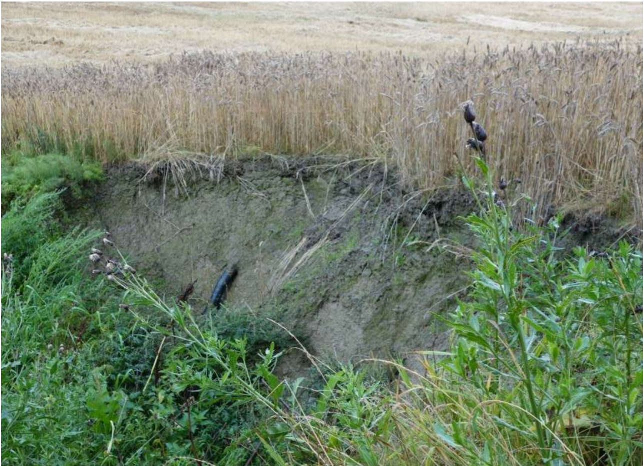
Rasområdet i skrent før innløpet av aktuell fangdam, høst 2015
