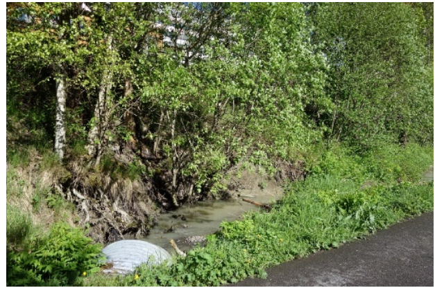
a) Kulvert under gangvei
