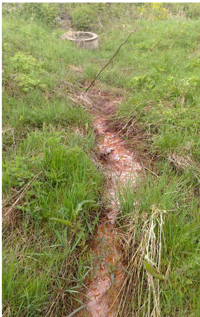
Vannsig i skråning
