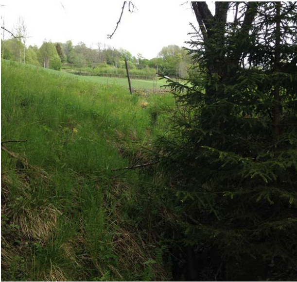
Øverst i sideløp der en bør steinsette et overløp for å stoppe erosjon.
