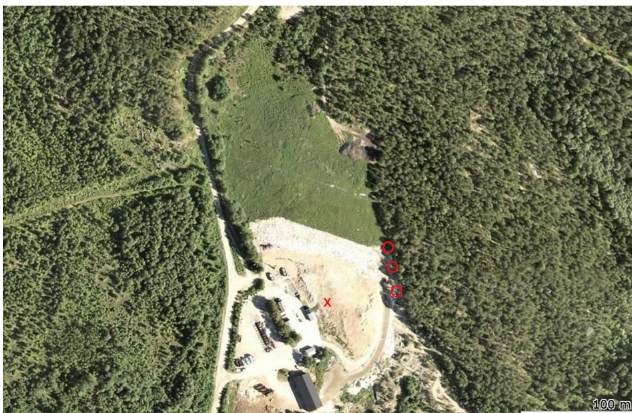
Figur 3 . Flyfoto over deponiet på Spillhaug. X viser området hvor det ble målt gass i flukskammer tidligere 2012 og 2013. Åpne ringer viser hvor måling i 2014 og 2015 ble utført med flukskammer over et nytt topp dekke lagt høst 2013 og forbedret i 2014.
