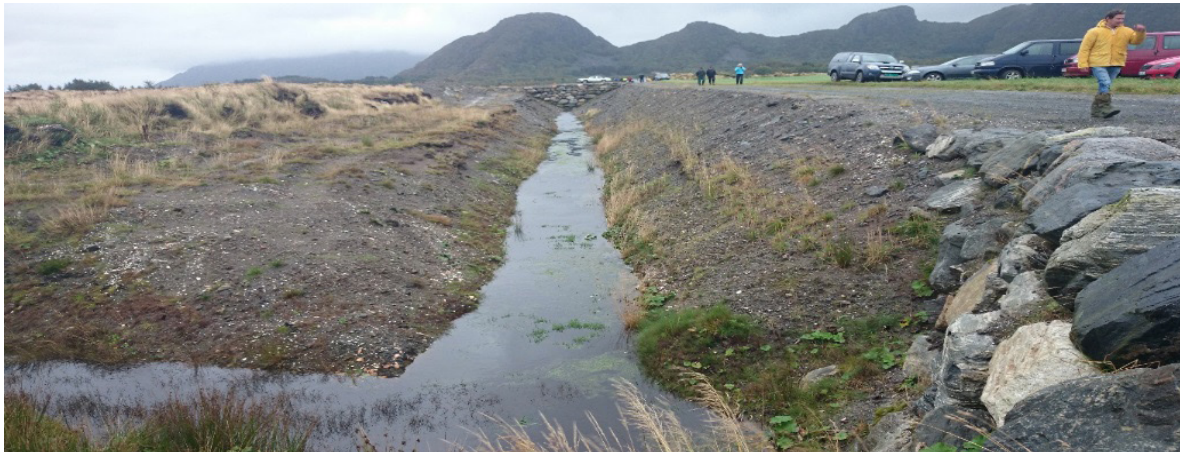
Opne kanalar på felt med omgraving som dreneringsmåte i Fræna. Drenerande mineraljord, grushaldig sandjord under opphavelag grunn til middels djup myr. Foto: Synnøve Rivedal, NIBIO.
