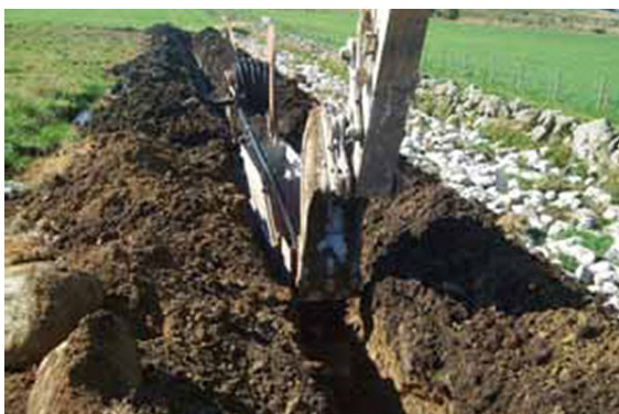
Bruk av grøftekiste i tilknytning til graveskuffemaskin. Utlegging av drensør og tilføring av filtermasse skjer ved at gravemaskina trekkjer med seg grøftekista. Foto: Gunn Elen Rosland.
