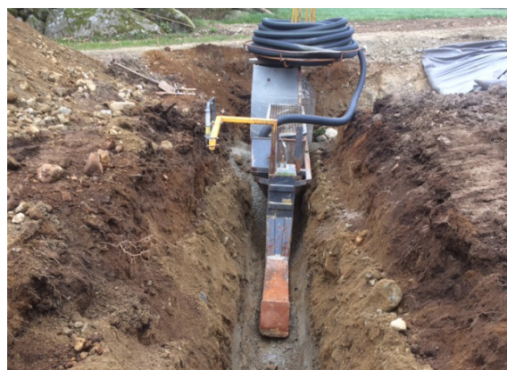
Nærbilete av grøftekiste med tilhøyrande grøftesko som slettar grøftebotnen slik at det vert jamt underlag for grøfterøyrret. Foto: Rangvald Gramstad, NLR.
