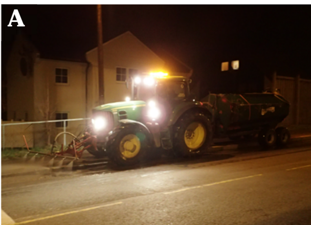
Bilde 5: Viser traktor med høytrykksdyser for bløtlegging av vei før feiing og vasking av vei som avsluttende tiltak etter feiing (A). Etter feiing tømmes sandfangene med sugebil (B).
