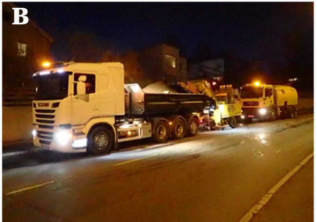
Bilde 4: Viser lastebil med oppsamlerkost (Broddway) som samler opp gateoppsop samlet i ranker (A og B). Bak oppsamlerkosten følger feie-/sugebil som fjerner gjenliggende masser og finere partikler (B).
