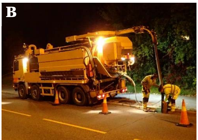
Bilde 5: Viser traktor med høytrykksdyser for bløtlegging av vei før feiing og vasking av vei som avsluttende tiltak etter feiing (A). Etter feiing tømmes sandfangene med sugebil (B).
