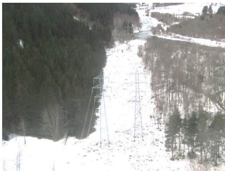
Fig. 19. Eksempel på vurderinger. Dette området ligger på Vestlandet som er en region med mye vind og kraftige snøfall, men vi er her i en skjermet lokalitet nede i en dal og det er djup jord med frisk fuktighet og gode muligheter for god forankring av rotsystemet. Vi har sjelden råte i gran på Vestlandet og vi kan regne med at trærne og deres rotsystemer er sunne og friske. Granskogen til venstre står tett, og trærne har blitt såpass høye at tynning og bredning er risikabelt. Her bør man følge med på utviklingen av høyde og d/h-forhold, og så forsøke å få til en hogst av hele skogbestandet i samarbeid med skogeier når man kommer til et tidspunkt da risikoen begynner å bli høy. Et alternativ er å beskjære trekronene inn mot kraftgata og toppe trærne, - begge deler kan gjøres fra helikopter. Til høyre for kraftgata er det en tett ungsog av løvtrær. Det er fortsatt mulig å bygge opp enkelttre-stabilitet her, dersom man regulerer treantallet ned til omkring 100 pr dekar. Man bør da sette igjen løvtrær som har loddrett, gjennomgående stamme og symmetrisk krone, jevnt fordelt i en bredde på omkring 25 m fra ytterfas. Foto: Hans Peter Eidseflot.
