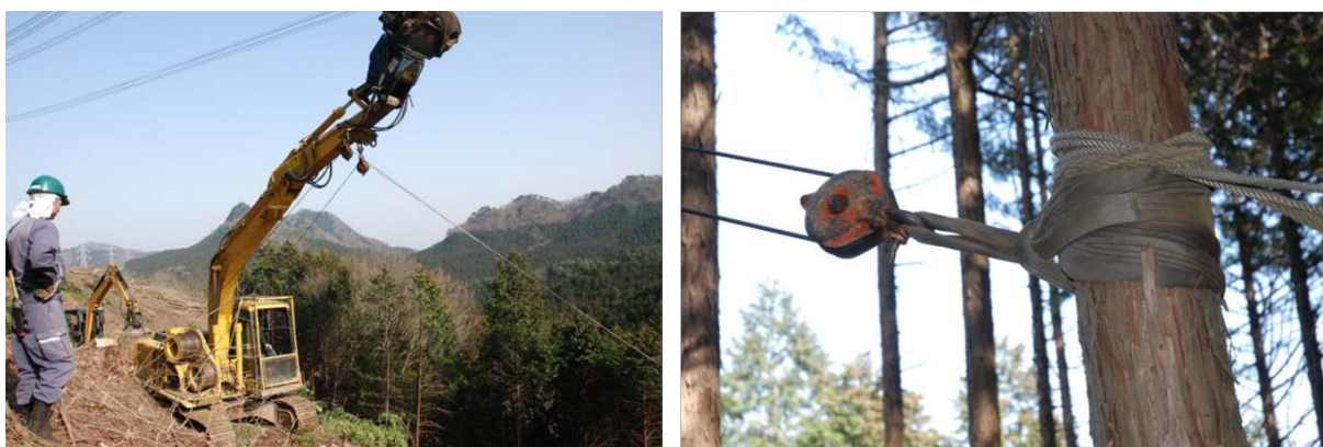
Figur 6. Gravemaskin med slepebane, rydding av veilinje.
