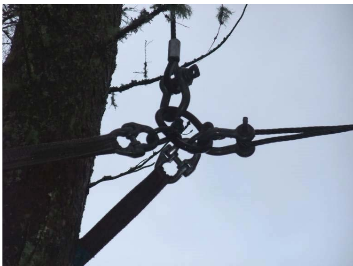
Figur 16. Endefeste med koblingsring. Bærekabel til høyre, barduner til venstre.
