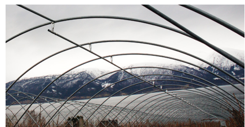
Elite tunnel frå Arctic Tunnel med nedsenka rør i toppen. Dette gir ein sterk konstruksjon der tau og plast kan strammast betre. Foto: Aksel Døving.
