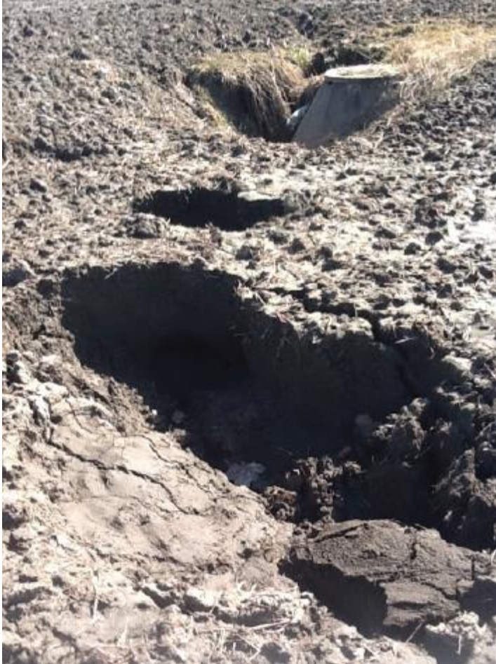
Bilde 5.11.2: Erosjonen rundt kummene kan være omfattende. Bilde fra april 2013.
