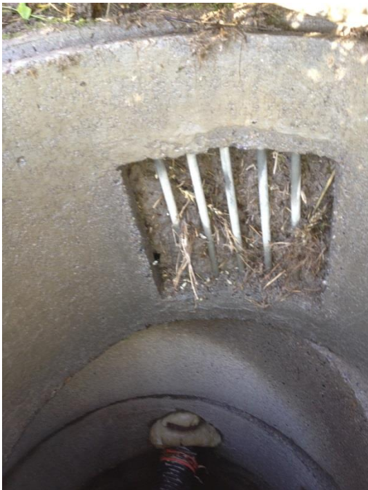
Bilde 5.12.1: Innløpsåpning på kum 2.
