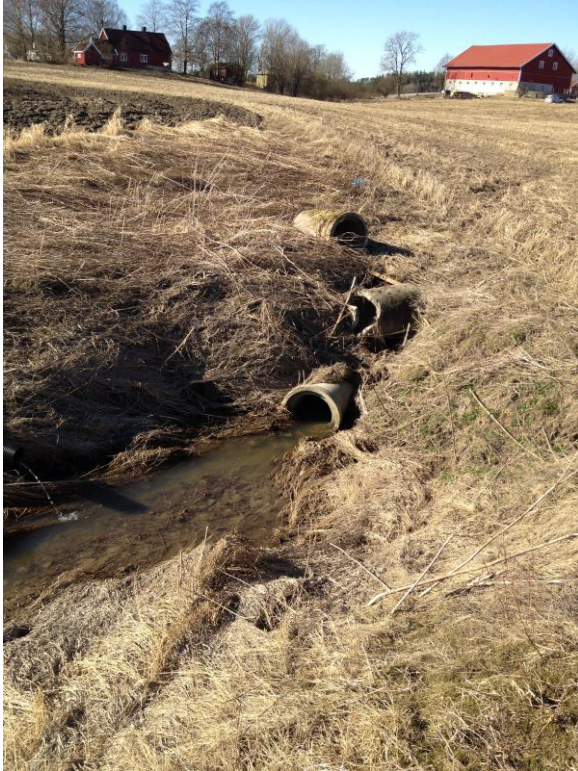
Bilde 5.2.2: Innløp fra grøft til lukningsanlegg på sørsiden av veien våren 2012
