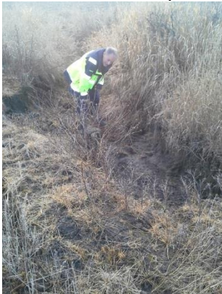
Bilde 5.15.2: Mye erosjon der overflatevannet renner ned i bekken.
