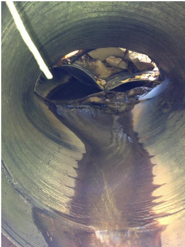
Bilde 5.11.1: Sammenpresset utløpsrør over fjellterskelen.
