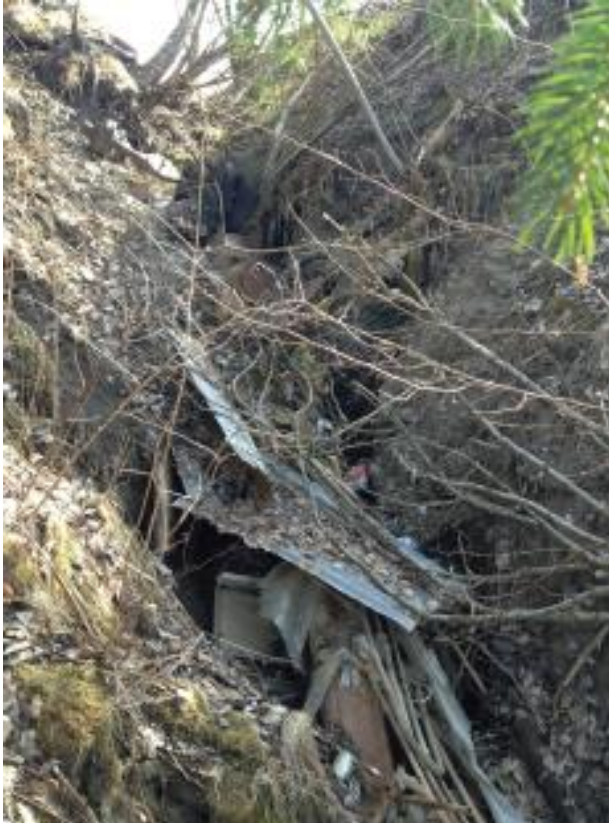
Bilde 5.10.2: Bilde tatt nedenfra i ravinen. Utløpet dekket av jord og søppel. Aktiv graving nedover i ravinen.
