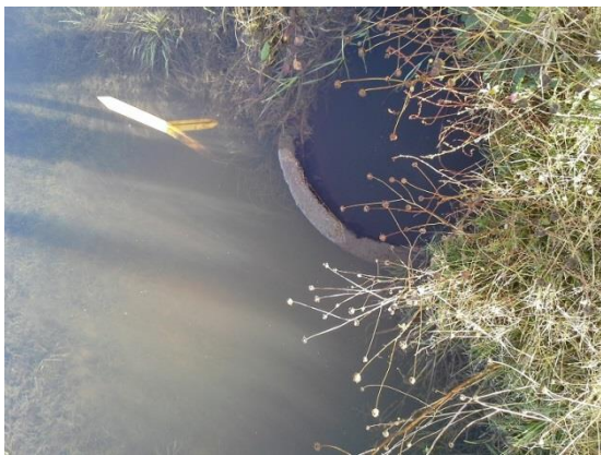
Bilde 5.16.1: Kum som står full av vann. Rørledning må være helt tett.
