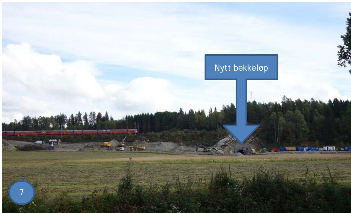
Figur 14. Tunnelinnslaget til Roåsbekken nordøst for gårdstunet på Ense. Bildet er tatt østover. Foto: A-G. B. Blankenberg.
