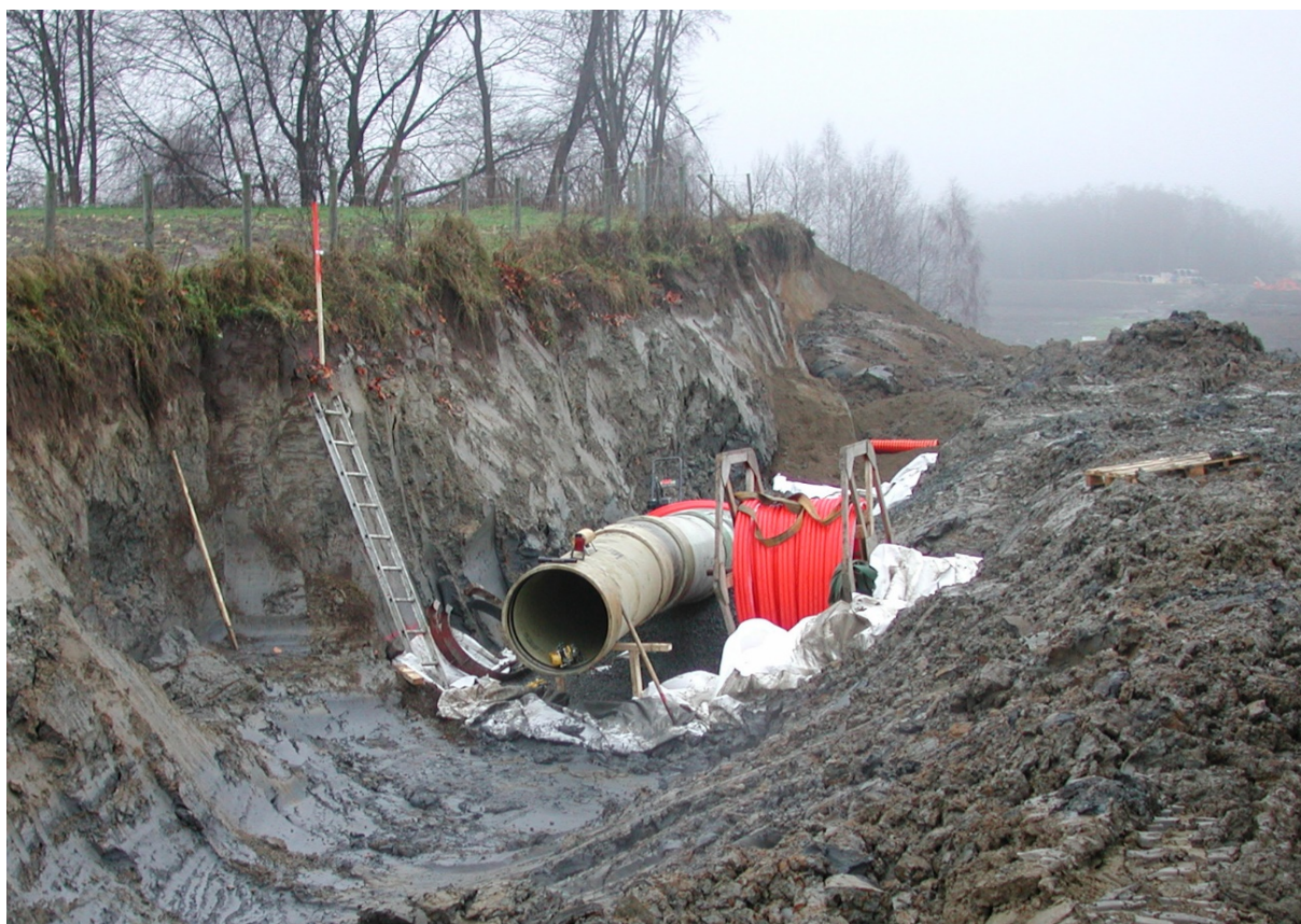
Figur 2. Legging av vannledning (Ø 800 mm) gjennom jordbruksområde i Lier 2005/2006. Foto: T. K. Haraldsen.
