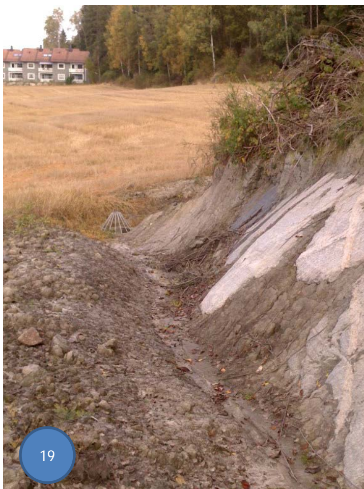
Figur 32. Langs jordekant på østsiden av jordet er det avskjæringsgrøfter som hindrer avrenning fra skogen å renne inn på jordet. Bildet er tatt av en nygravd grøft og kum på nedsiden av en åkerholme nord på jordet. Bildet er tatt nordover. Foto: A-G. B. Blankenberg.
