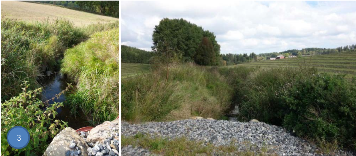
Figur 10. Passasje over bekken mellom Ense og Tallaksrud, og kulvert under passasjen. Bildet til venstre er tatt sydoover og bildet til høyre er tatt nordover. Foto: A-G. B. Blankenberg.
