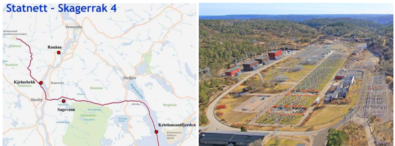
Figur 57. Viser kabeltrasé og målestasjoner samt panorama Kristiansand trafostasjon.
