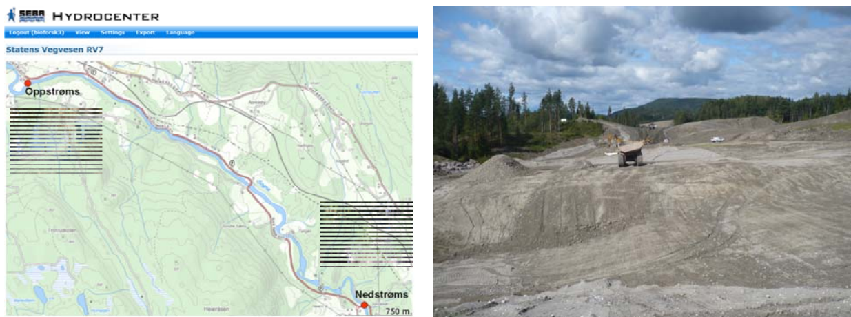
Figur 11. Nettside med kart over stasjoner samt bilde av anleggsområde med fylling og skjæring.
