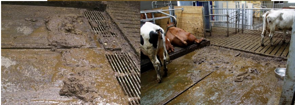
Bilde 9, 10 og 11. Kyr som ligger med halen i skrapearealet og hauger med møkk i gangarealet som blir liggende igjen fordi skrapene ikke går helt over rista
