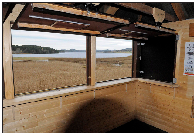
30. Det er lurt å bygge mindre skyveluker på store vinduslemmer. Dette for å ikke skremme fugler som sitter nært tårnet, når man åpner de store lukene. Vindusluker anbefales framfor vindu.
