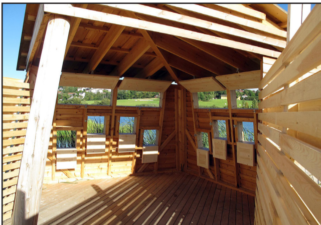
26. Stor oppholdsrom som gir skjul for vær og vind. Flere lemglugger kan åpnes for rullestolbrukere eller mindreårige/korte personer.
