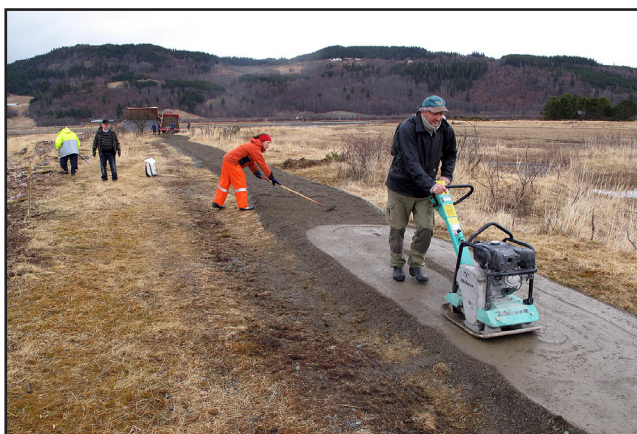
42. Bruk gjerne vibrasjonsplate for å komprimere grusen i stien, slik at rullestolbrukere får gode betingelser fra første dag.
