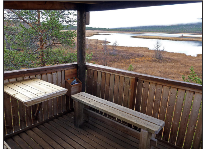
106. Bord som er hengslet mot vegg og som kan legges ned. Skammel som kan flyttes.
