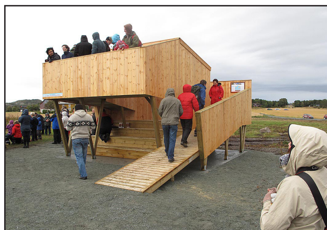
23. Anlegg med mulighet for opphold under tak i første etasje og rullestoltilpasset adkomst til balkong to meter over bakkeplan.
