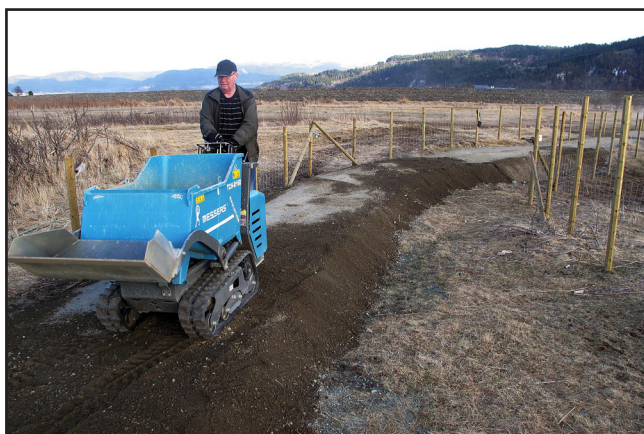
41. Beltegående selvlastende kjøredoninger med tipp, er ideelle for legging av stier i krevende terreng og gir ingen kjøreskader. Slikt arbeid kan også gjøres på dugnad, siden slike maskiner er å få leid.
