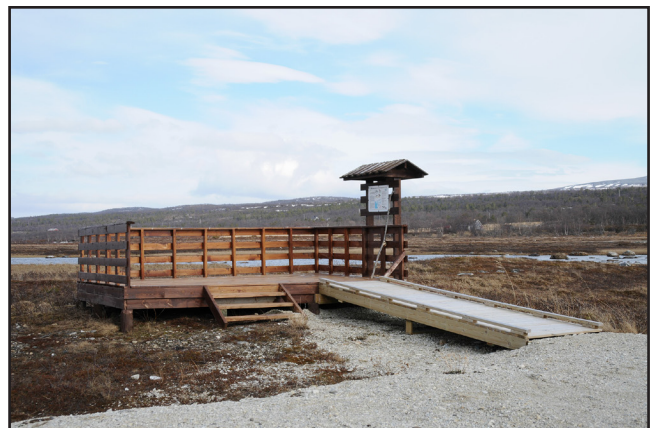
79. Fugleplattform ved Viekker, Porsanger, Finnmark.
