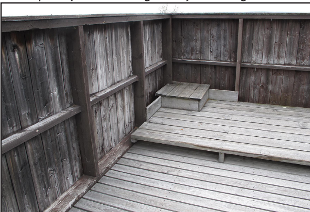
39. På balkonger og andre ståsteder, er det lurt å lage små flyttbare skamler slik at mindreårige kan komme høyt nok til å se ut. Her ser vi fastmonterte løsninger som gir ulike høyder. Forsenkninger i balkongveggene, kan også være nyttige for lav personer, mindreårige og rullestolbrukere.
