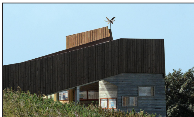
34. Fugl med «propellvinger» virker effektiv med på å holde kråker og andre fugler som bruker anlegget som sitteplass, når det ikke er folk til stede. Dette gjør at det blir mindre fugleskit og gulpeboller som medfører mindre påvekststalger som igjen gjør at treverket blir mindre glatt når det blir vått. Se bilde 100, side 48, hvordan påvekststalger «blomstrer» på steder med fugleskit.
