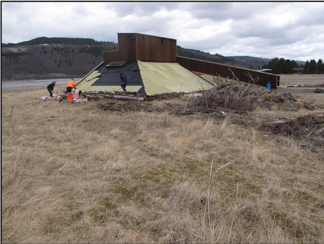
35. Bruk gjerne markplater på grunnmursplasten, hvis det anlegges torvtak. Det er med på å holde mer vann i taket og vekstforholdene blir jevnere.
