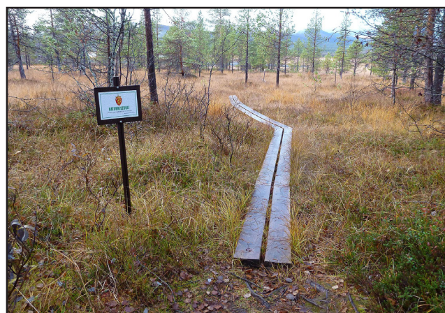
44. For å unngå tråkkskader over myr og våte partier, er det lurt å legge klopping på stianlegg som fører til anlegget. Dette gjør at man kan besøke området i småsko.
