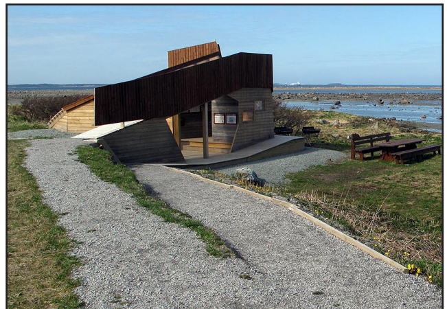
27. Stort anlegg med amfi i underetasje som er godt egnet for undervisning og da spesielt ved dårlig vær. Anlegget har to mindre balkonger uten tak som er rullestoltilpasset og som gir le for enkelte vindretninger.
