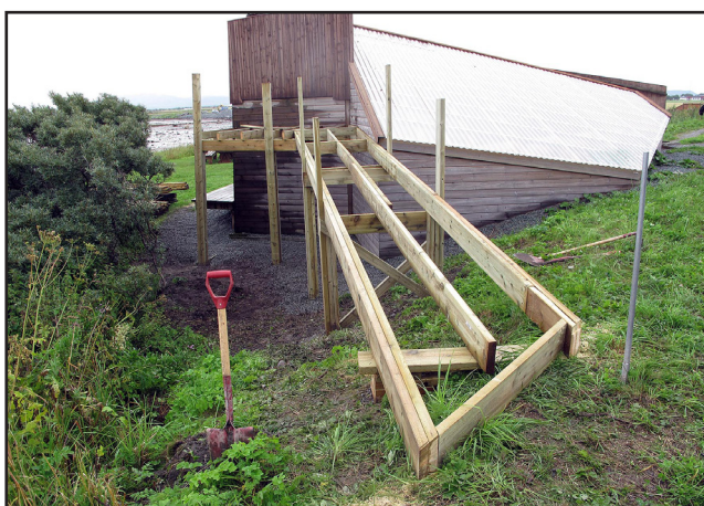
46. Etter at et anlegg er oppført, er det ikke så uvanlig at man oppdager mangler eller forhold som gjør at man ønsker å utvikle anlegget «trinn II». Her ser vi at det etableres en balkong som innfrir universal utforming, samt at det gir oppholdssted med le på en ny side av anlegget.
