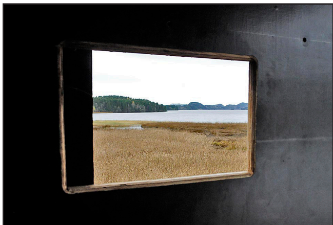
30. Det er lurt å bygge mindre skyveluker på store vinduslemmer. Dette for å ikke skremme fugler som sitter nært tårnet, når man åpner de store lukene. Vindusluker anbefales framfor vindu.
