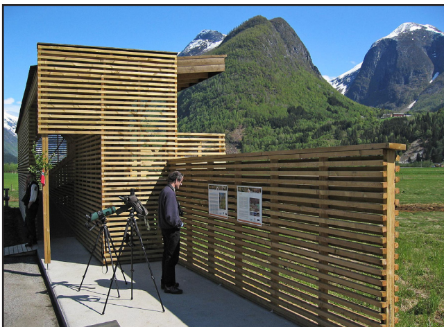
28. Rullestoltilpasset anlegg med balkong 1,5 meter over bakkeplan. Anlegget har også skjerming mot adkomst som også kan brukes til informasjonsplakater.
