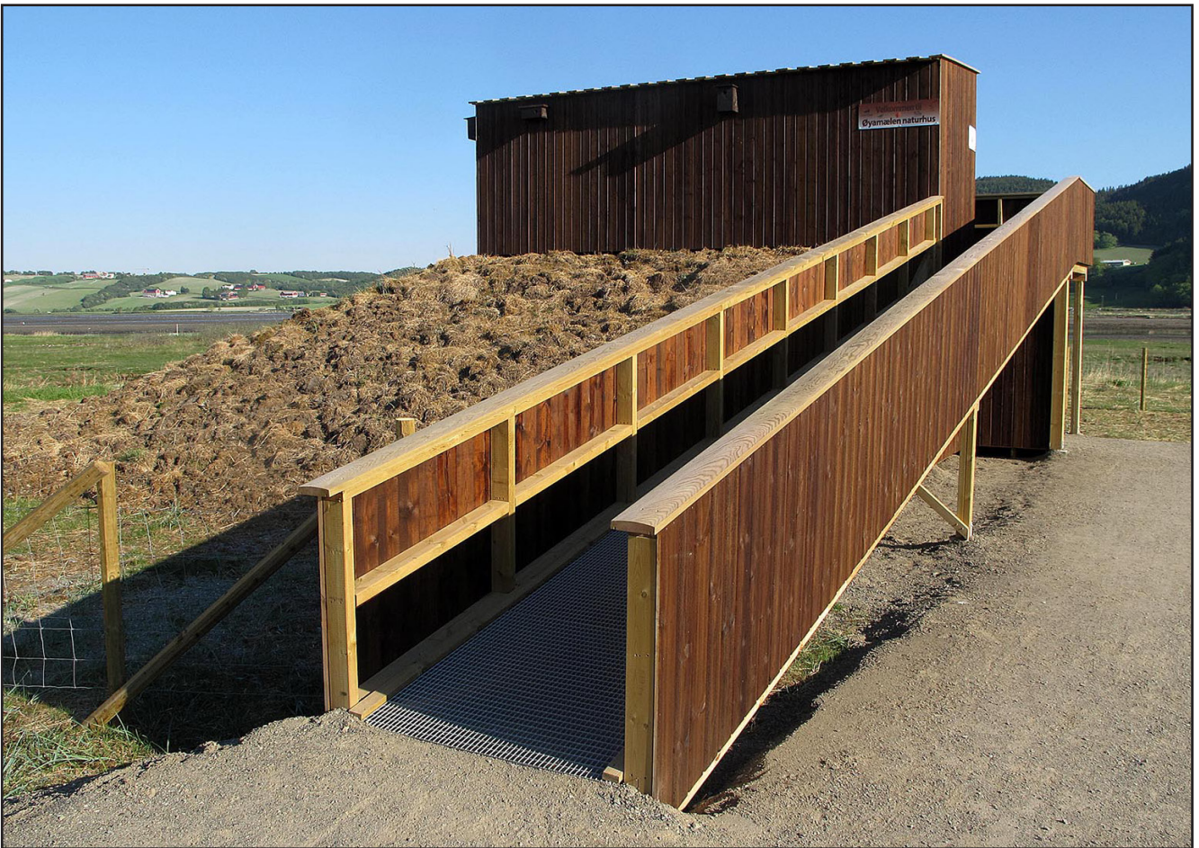
4. Dette anlegget har 100 % universal utforming på bakkeplan. Øvre balkong innfrir ikke krav til ideell stigning i regelverket for universal utforming, men adkomsten er allikevel rullestoltilpasset.
