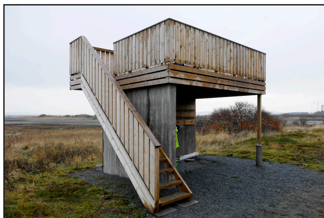
32. Bruk av betong i konstruksjonene er ofte lurt. Spesielt på ståsted og standplass for bruk av stativ til teleskop og fotografering. Et betonggulv er også tilnærmet vedlikeholdsfritt.
