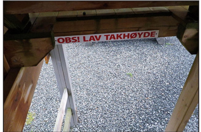
36. Viktig å markere steder med lav takhøyde eller andre forhold som kan være utfordrende for publikum som til eksempel opplysninger om at partier kan være glatte osv.
