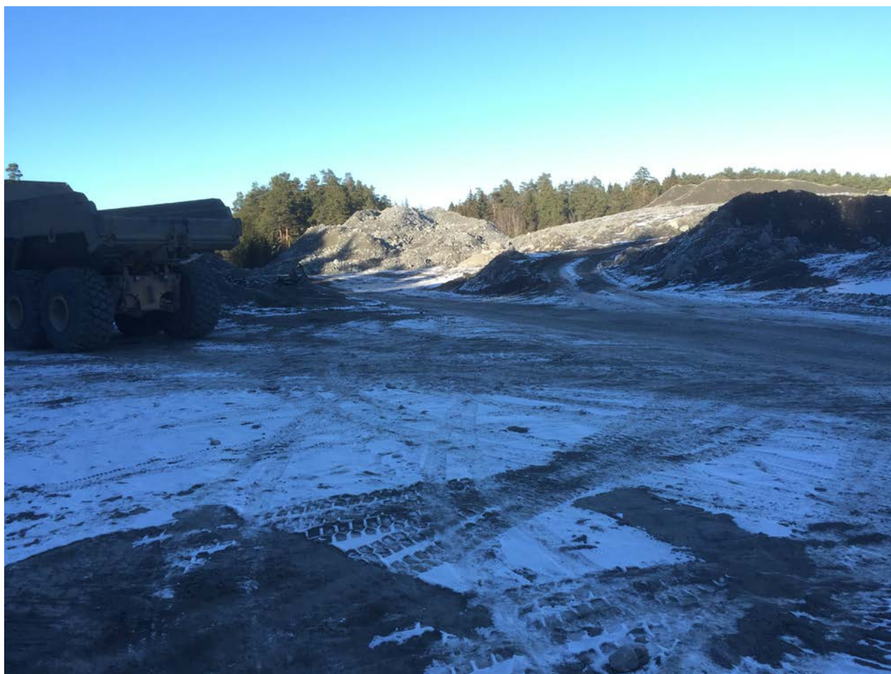
Figur 3. Deponiet på Langemyr under oppfylling vinteren 2015/2016.
