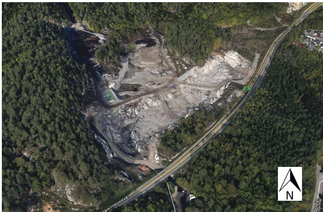
Figur 4. Anleggsområde og deponi ved Langemyr sommeren 2014.
