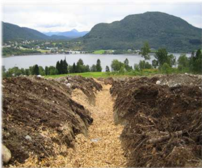
Flis i grøft
