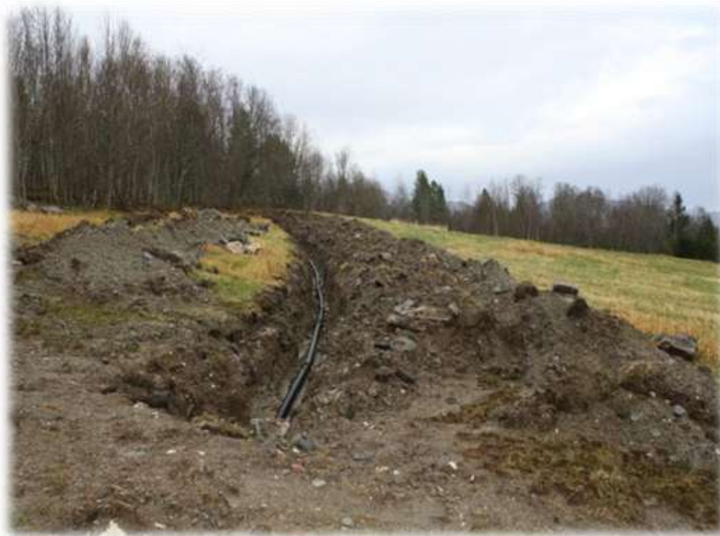
Dreneringsarbeid på Osmarka, høsten 2011
