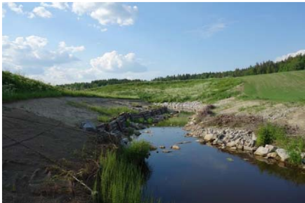
Forbygging med stokker, steinsetting og kokosmatter som tiltak mot kanterosjon. Svinndal
