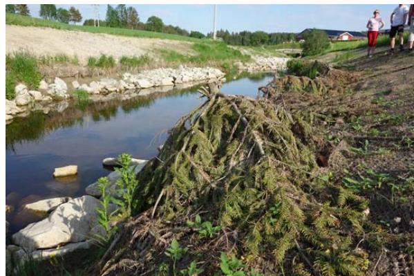
Utprøving av grantrær som tiltak mot kanterosjon. Svinndal
