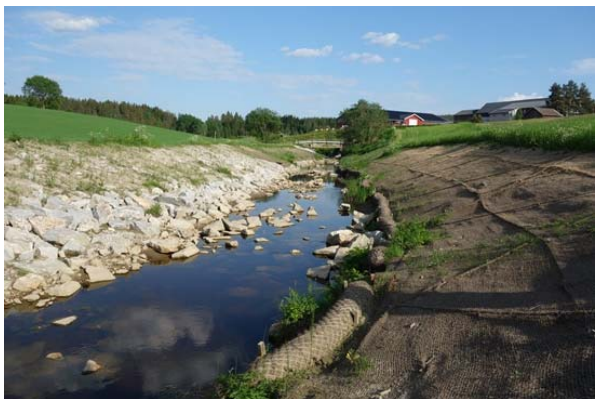
Steinsetting og bruk av kokosmatter som tiltak mot kanterosjon. Svinndal
