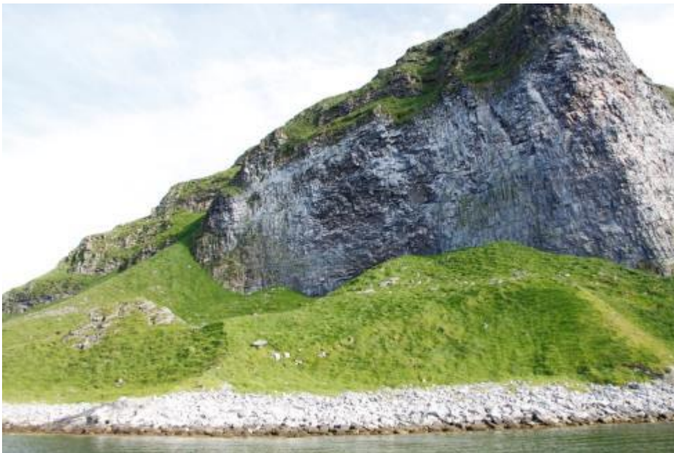
Figur 5. Vestveggen sett fra nordsiden av Vedøya. (Foto: T. H. Carlsen).
