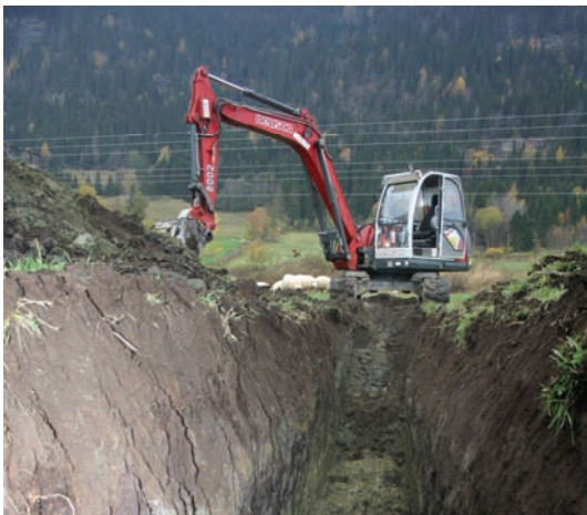
Figur 52. Når en Histosol skal tas i bruk som jordbruksjord, må den først grøftes for å drenere bort overflødig vann. Grøfting stopper torvdannelsen og fører til en sammensynking av myra. Etterhvert vil torvlaget "brukes opp" og myra tynnes ut. Foto: Ragnhild Sperstad
