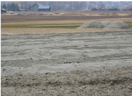
Figur 95. Her er en variant med påfylt sand over tett siltjord for å bedre luftvekslingen i jorda og for å komme høyere opp fra grunnvannsspeilet. Foto: Ragnhild Sperstad
