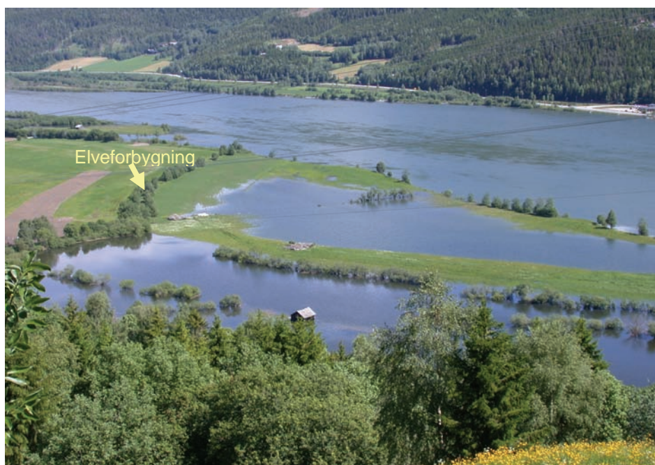
Figur 39. Bildet viser en flomstor Gudbrandsdalslågen i Fåvang 24.juni 2005. Se kartutsnitt i figur 38. Trerekken til venstre for det oversvømte området står oppå en elveforbygning som hindrer vannet i å gå videre innover elvesletta. Det er Fluvisols på begge sider av forbygningen, da jordsmonnet til venstre for forbygningen er altfor ungt til å ha utviklet jordstruktur. Denne jorda vil derfor ha de samme egenskapene som jorda til høyre for forbygningen, bortsett fra de årlige oversvømmelsene. Fluvisols trenger ikke å være flomutsatt i dag, men har vært det i nær fortid. Foto: Ragnhild Sperstad
