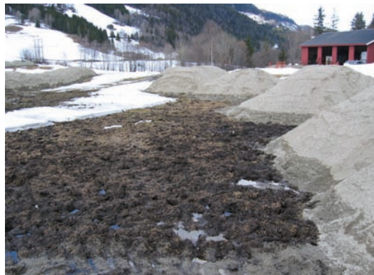
Figur 96. Den vanligste varianten er påkjørt mineraljord over organisk jord (myrjord) for å bedre jordas bæreevne. Foto: Ragnhild Sperstad
