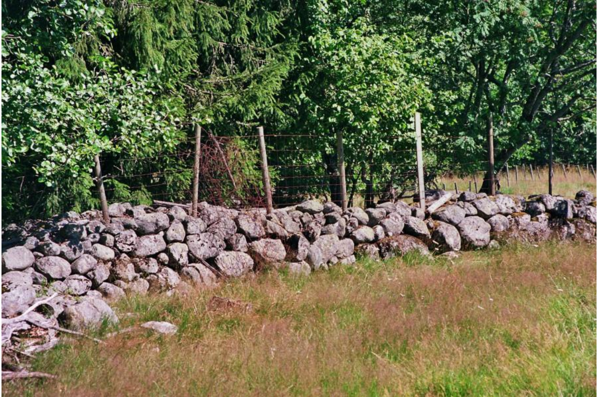
Figur 16. Ved å sette gjerde på toppen av steingjerdene får en god nedbeiting helt inn mot steingjerdet og hindrer både gjengroing med lauv og tråkkader på steingjerde om gjerdet settes i bakkant. Illustrasjonsfoto fra Tovdal, ES 2007.
