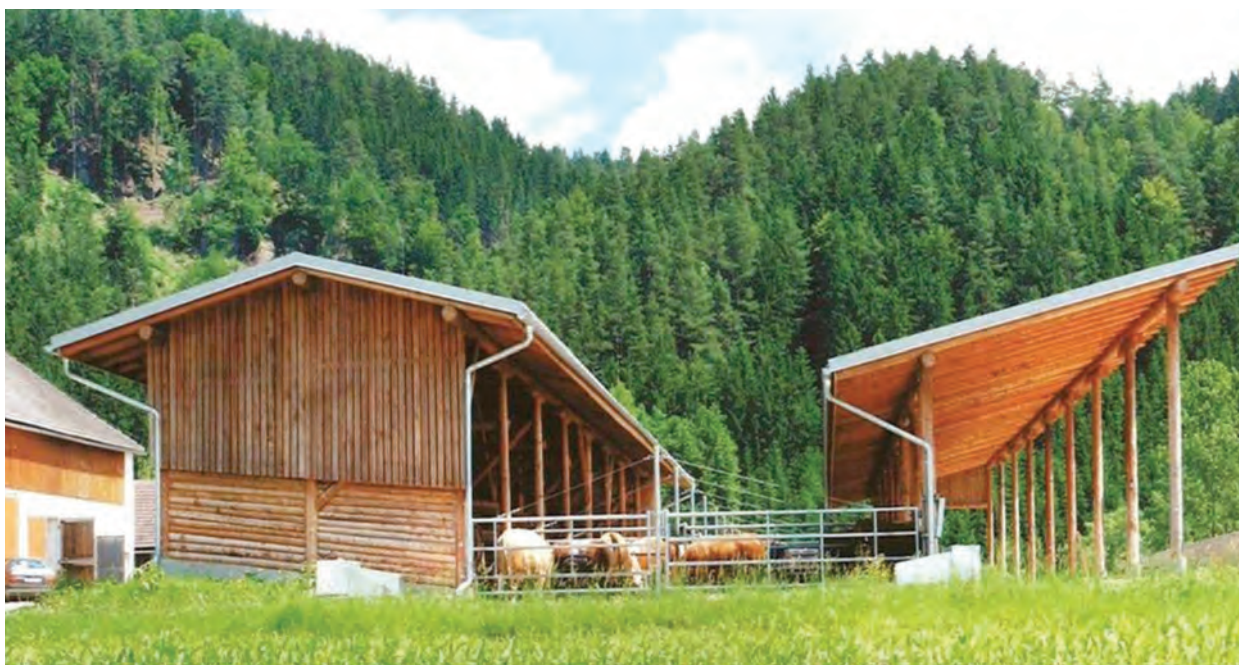
Kjøttfeffjøs i Sveits. Liggeavdeling og fôring i to atskilte bygg med skrapeareal mellom. Foto: Tore Stokke.
