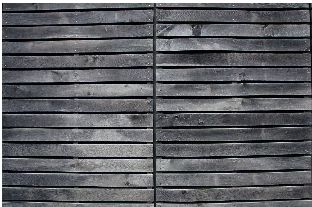
Liggende, åpen kledning i osp med mye vridning i bordene.
