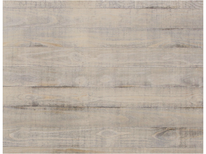
Liggende dobbeltfalset kledning, uten overlappende bord.
