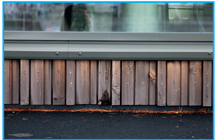
Utsnitt 2. Kledning mot asfalt
