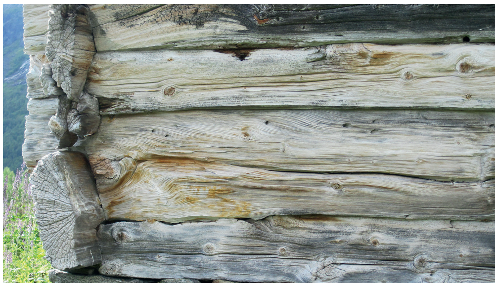
Eldre fasade preget av mekanisk erosjon. Vigdalen, Luster. Bilde: NIBIO/Lone Ross Gobakken
