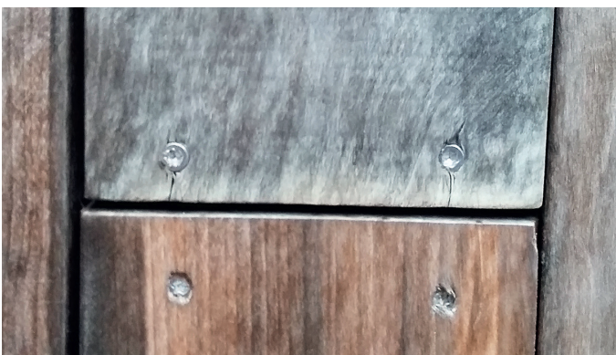
God avstand mellom kledningsbrodene.
