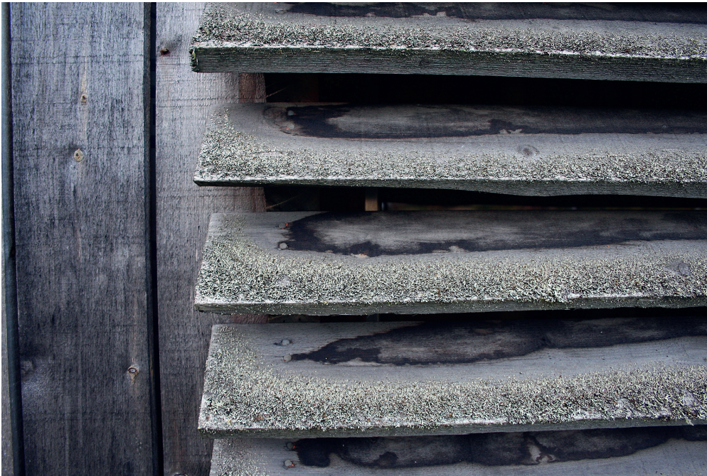
Lav på liggende, skråstilt spilekledning.
