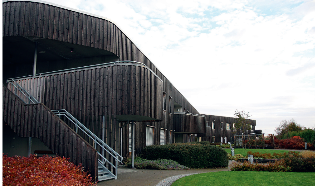
Vestvendt kledning i furu kjerneved. Fire år gammel. Stavanger.
