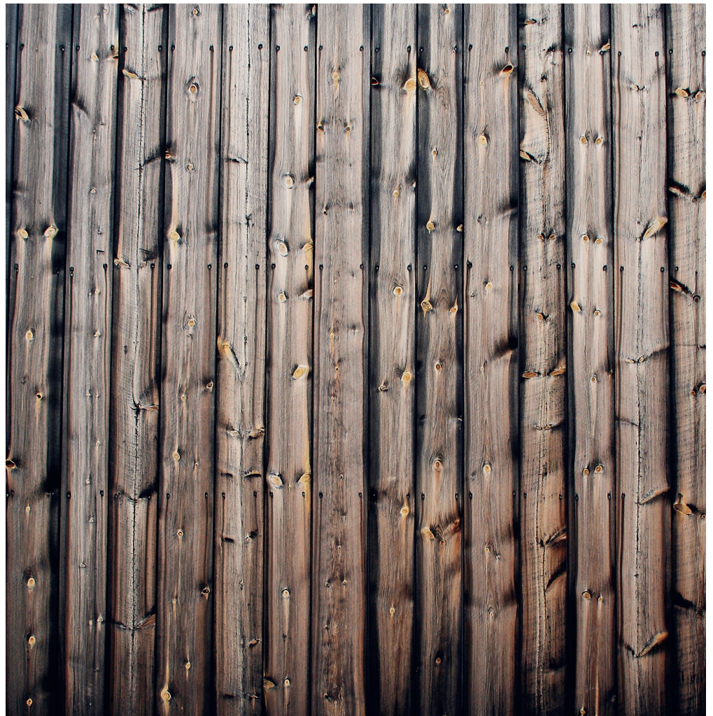
Kledning i stående furupanel. Kledningsbordene består hovedsakelig av kjerneved, men har noe yteved i kanten av bordene.
