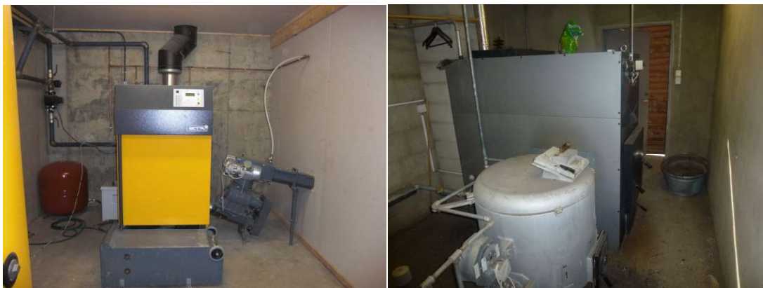
Figur 3. Til venstre en fliskjel beregnet på tørr flis. Asken skrues ut til beholderen i front av kjelen. Til høyre en kjele med såkalt for-ovn, noe som gjør at den kan benytte råere flis.
