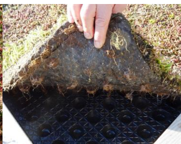
Røttene søker ned i koppene i dreneringslaget i løpet av andre vekstsesong
