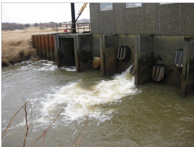
Figur 2. Utpumping av vann fra Skas-Heigre-feltet. Foto: NIBIO.
