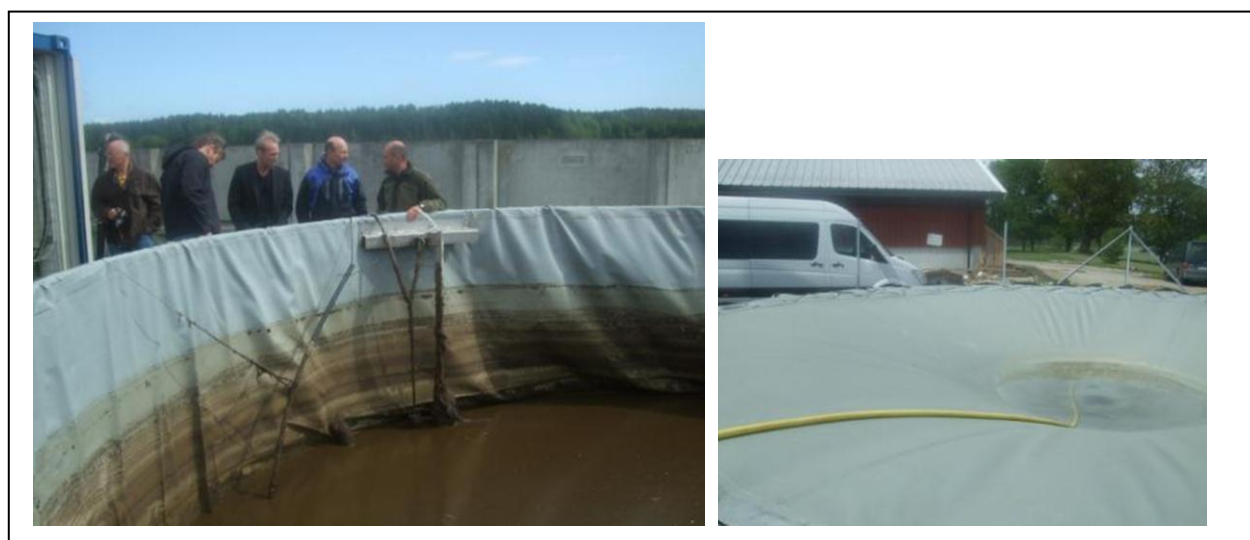
Til venstre: Halve reisefølget samlet ved en oppsamlingstank for biorest som pumpes over til sluttlager. Foto A. Lyche. Til høyre: Når gasslageret ikke har faste vegger kan det samle seg vann (og snø og is) i duken når gasstrykket er lavt. På Tomb 24. mai 2011 måtte vann fjernes med hevert. Foto AK Læs.
