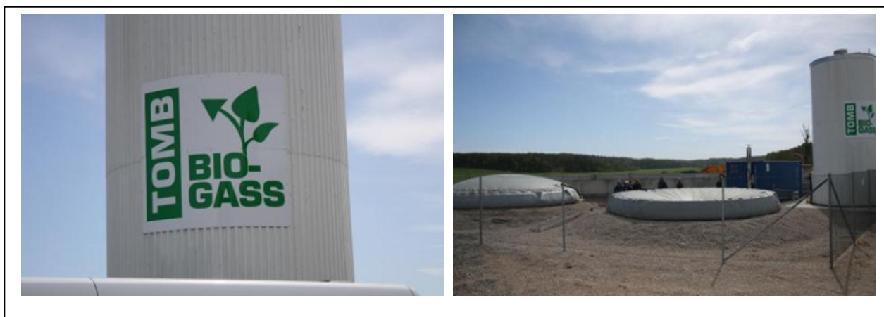
Til venstre: Flott skilt på tanken som rommer matavfall. Til høyre: Oversikt over anlegget, med to reaktorer og tank for matavfall. Anlegget er gjerdet inn. Foto: A. Lyche.
