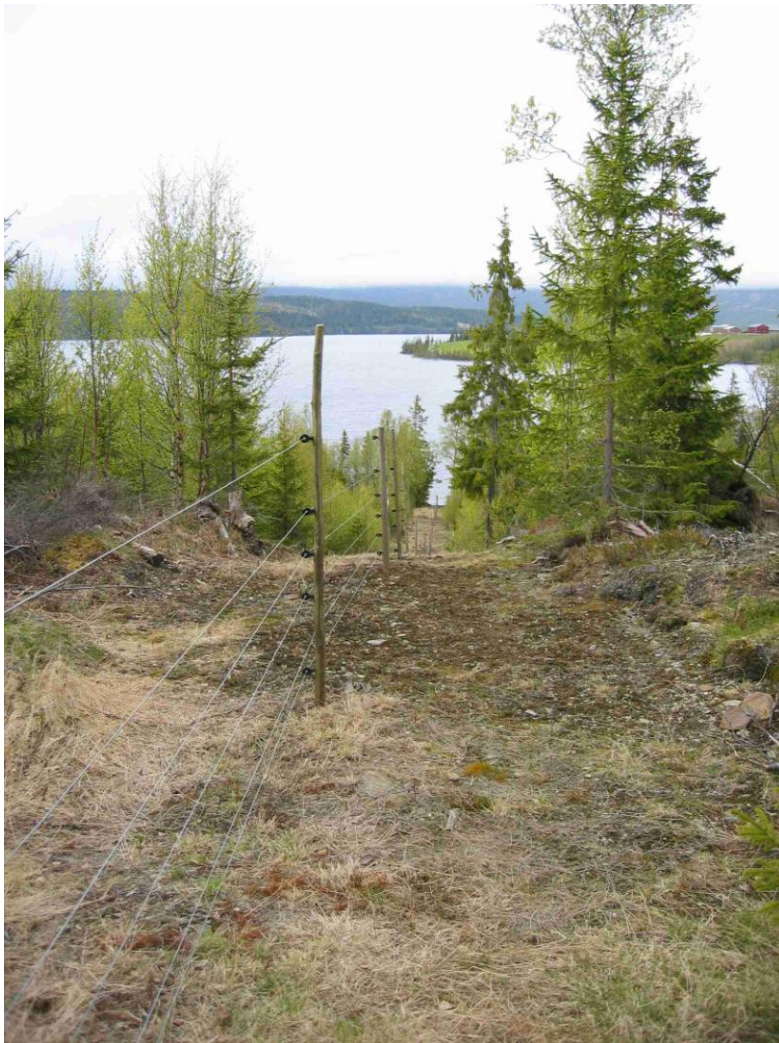
Figur 1: Elektrisk "rovdyrnett" gjerde etter DNS standard (foto: Inger Hansen)
