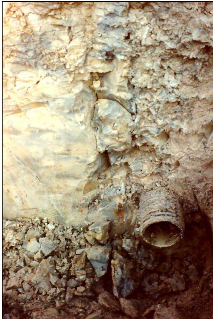
Figur 19. Nedre del av jordprofil på planert leire i Lodding delfelt 106/107, med tydelige sprekker over drenerørret. Foto: L. Øygarden, Bioforsk.
