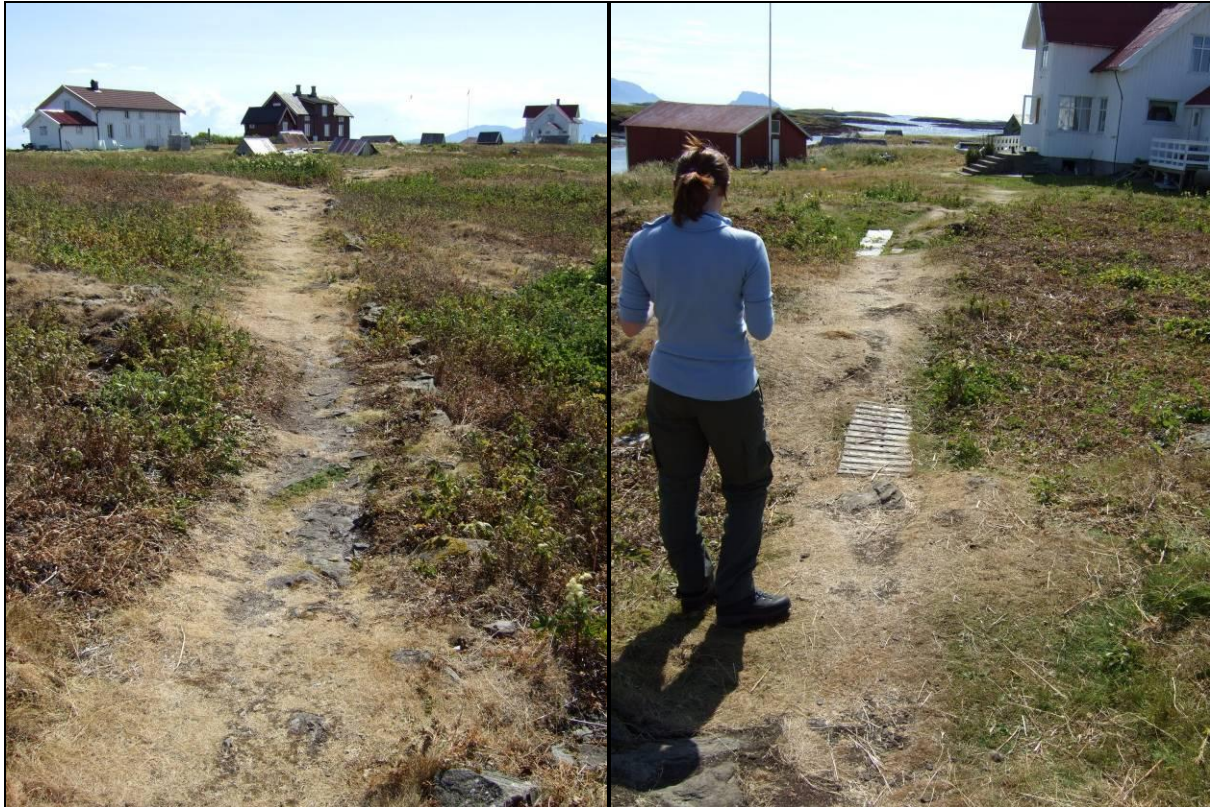
Figur 13. Stien er delvis bygd opp med skjellsand, grus og steiner i kanten (t.v.); treplanker og plastmatter (i bakgrunn) er lagt over fuktige partier ved bebyggelsen (t.h.) (foto: A.J. Lukkassen).
