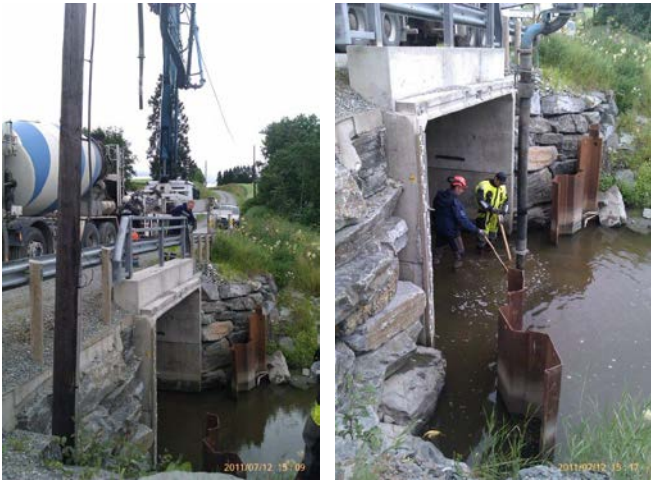
Figur 2. Tetting av lekkasjen under Crump-overløpet, juli 2011.
