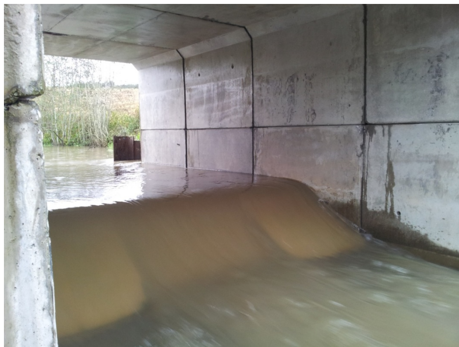
Figur 1. Vannstrømmen gjennom Crump-overløpet i Hotranelva.
