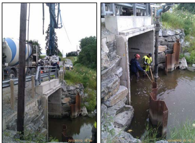
Figur 2. Tetting av lekkasjen under Crump-overløpet, juli 2011.
