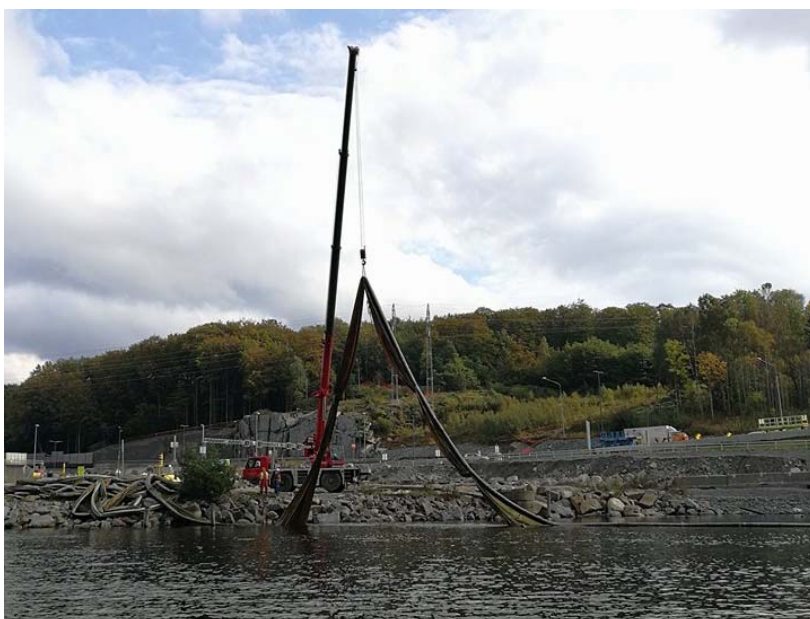
Figur 7. Den siste siltgardinen heves ved hjelp av kran. Siltgardinen er bundet sammen med flyteslangen hver 4-6 m.
