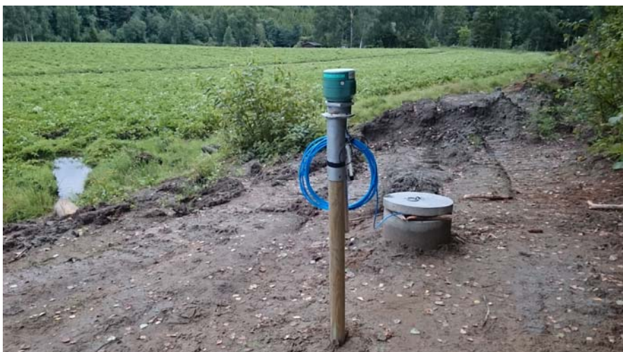
Figur 11. Grunnvannsbrønn og automatisk overvåking Rimstadmoen.
