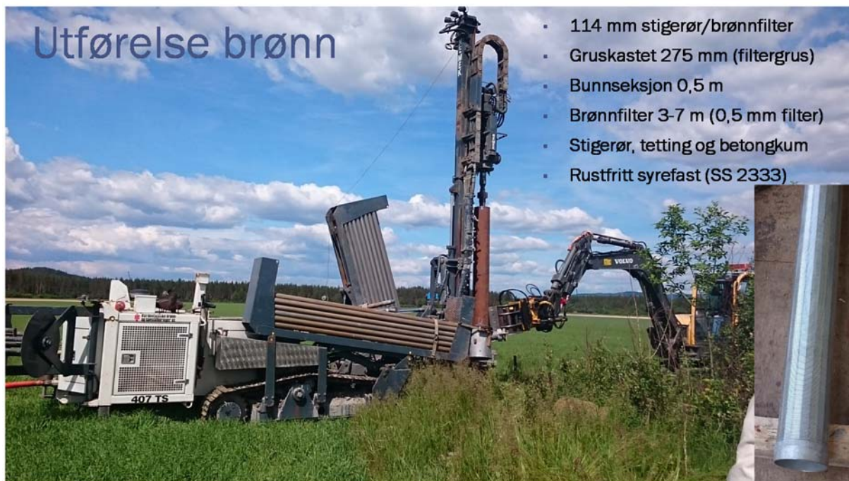
Figur 3. Plassing av ny grunnvannsbrønn på Haslemoen i Våler kommune.
