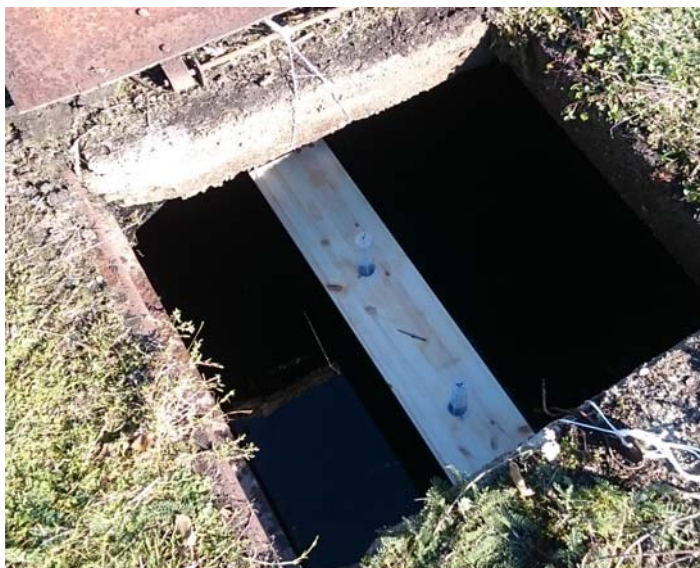
Figur 48. Montering av prøvetakere i brønnen.
