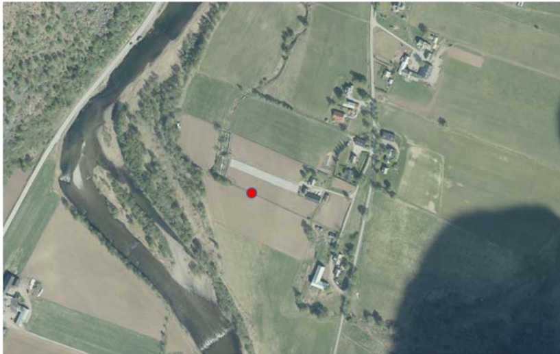
Figur 30. Foto som viser skissert plassering av overvåkingsbrønn ved Hauge i Lærdal.
