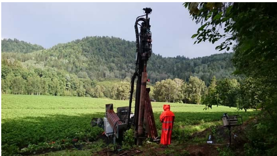
Figur 10. Innledende boring på Rimstadmoen for avklaring av løsmasser og grunnvannsforhold ned til 11 m dyp.
