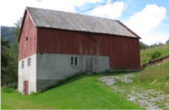
En hovedidé ved enhetslåvene var å utnytte tyngdekrafta. Fôr på toppen slippes ned til dyra på midten, og møkka tas ut fra kjelleren. Et nøkternt eksemplar fra Narvik i Nordland, typisk med snaut tankutspring. Foto BOA.
