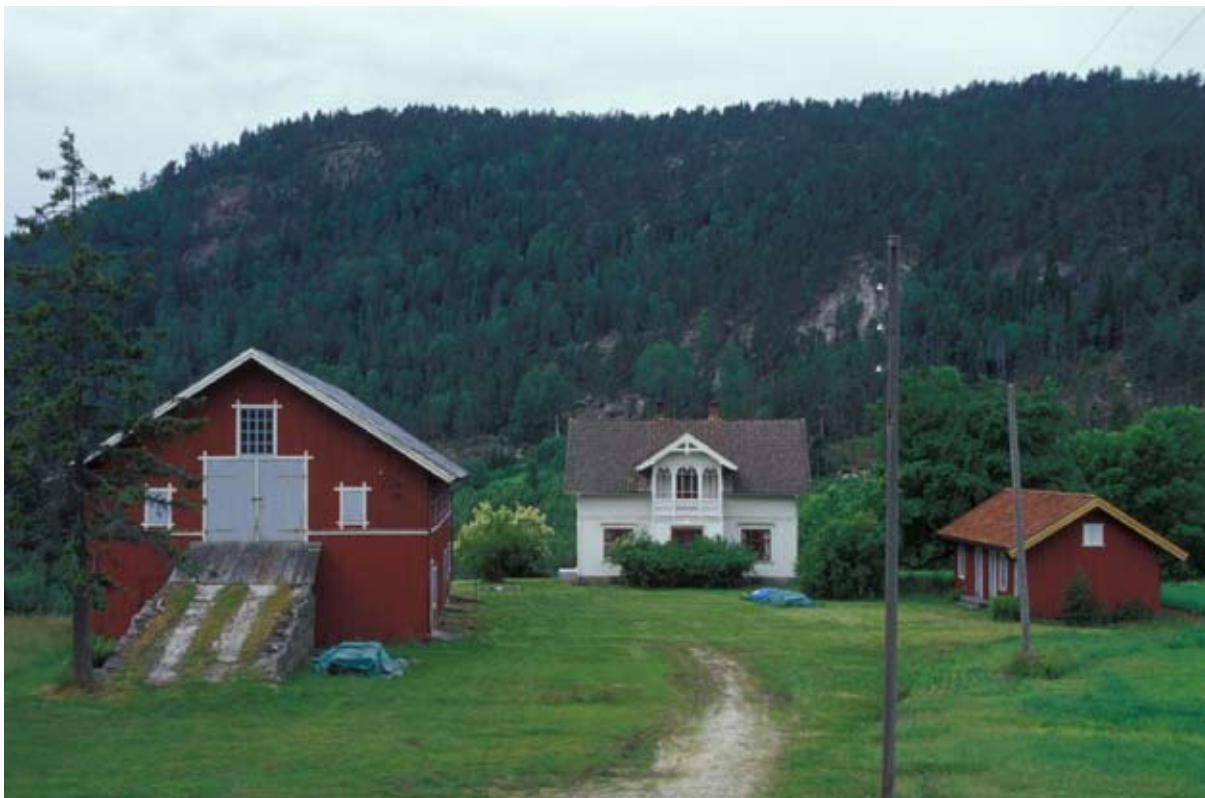
I gjennomsnitt er gårdstunet på 3 441 m 2 og har 3,87 bygninger. Eksempel fra Nome i Telemark. Foto OSP.
