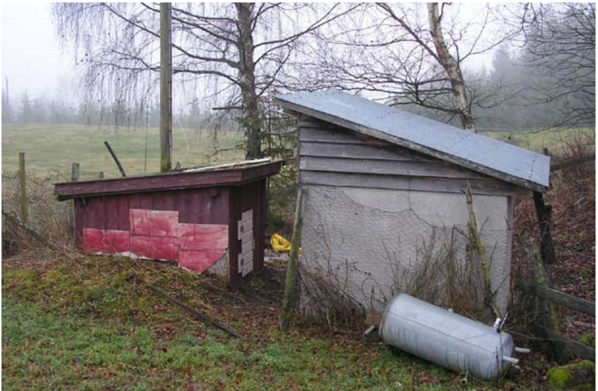
Pumpehus, gjødselkum og hus over dieseltank er blant hustypene som havner i boksen Annet uthus. Denne kategorien dekker 4 % av bygningsregistreringene. Foto KAS.
