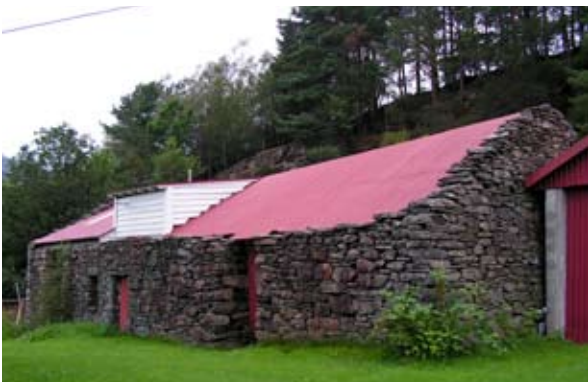
Det finnes en sterk tradisjon for steinbygging i Hordaland og ytre Sogn. Ofte er gavlene og fjøsdelen i løa av stein, men også hele veggflater kan være av stein. Meland i Hordaland. Foto KAS.
