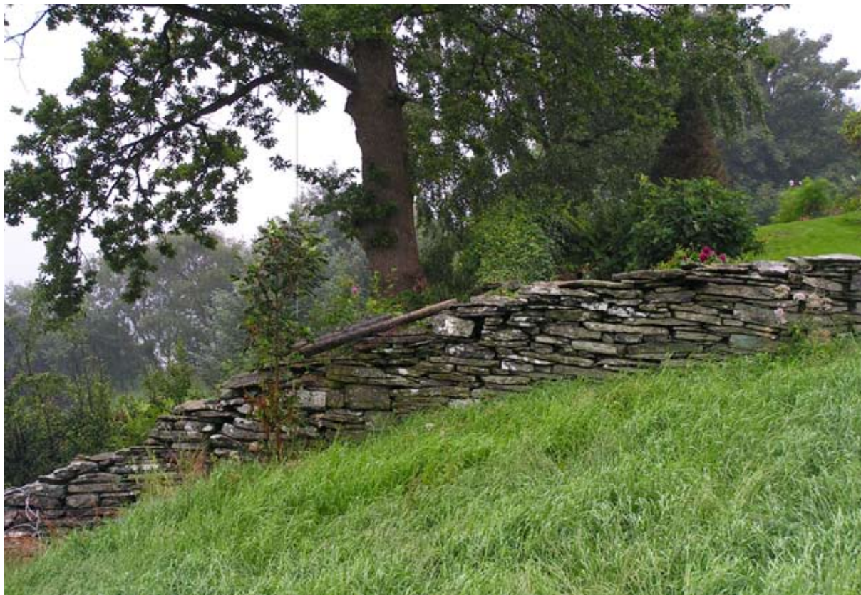
I bratte bakker stilles det ekstra krav til gjerdenes fundamentering og konstruksjon. De er imponerende byggverk mange steder. Finnøy i Rogaland. Foto KAS.
