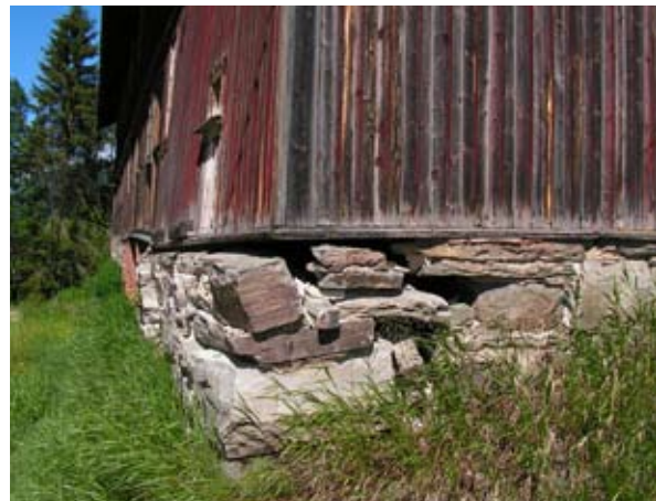
I tilstandsvurderingen benyttes en stikkordliste for elementer som er særlig viktige for tilstanden til en bygning. Vi ser bl.a. på fundament, tak, pipe og vinduer. Foto KAS.
