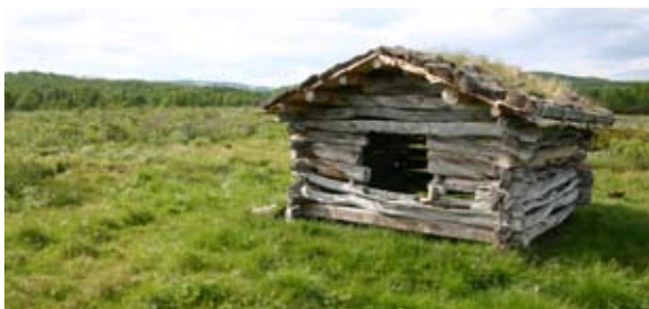
Utmarksløer var ofte bygd av bjørk. Ujevne krokete stammer ga god lufting. Hedmark. Foto YNR.
