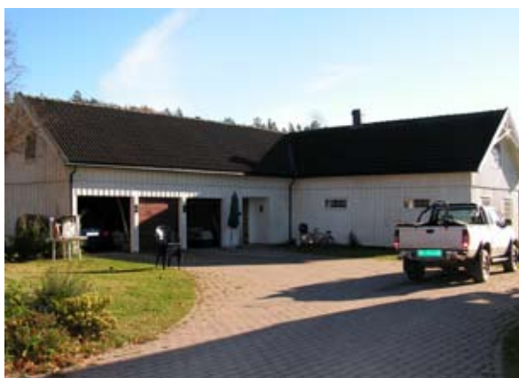
Bryggerhuset er ombygd til bolig og utvidet med garasje, men det opprinnelige preget er bevart. Vestfold. Foto GAM.
