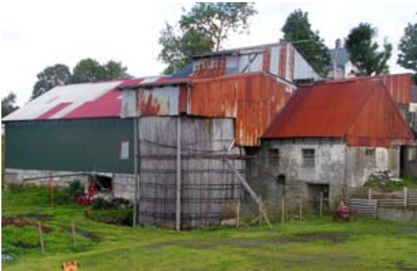
Særlig på Vestlandet ser vi mange kompakte uthus, ofte med påbygg fra ulike tider. Stålkledde vegger ser vi også mest av på Vestlandet. Radøy i Hordaland. Foto FRB.
