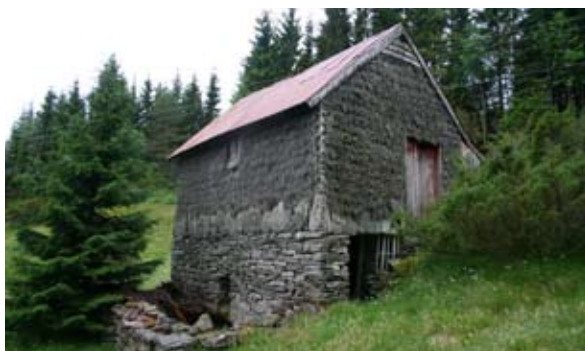
Grindbygd løe med brakekledd vegg (flettverk av eier) og fjøs i underetasjen. Osterøy i Hordaland. Foto FRB.
