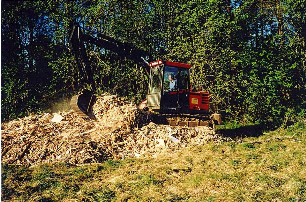
Bilde 13. Bygging av flisveg med returtre. Foto: Gjermund Liereng, 2003.
