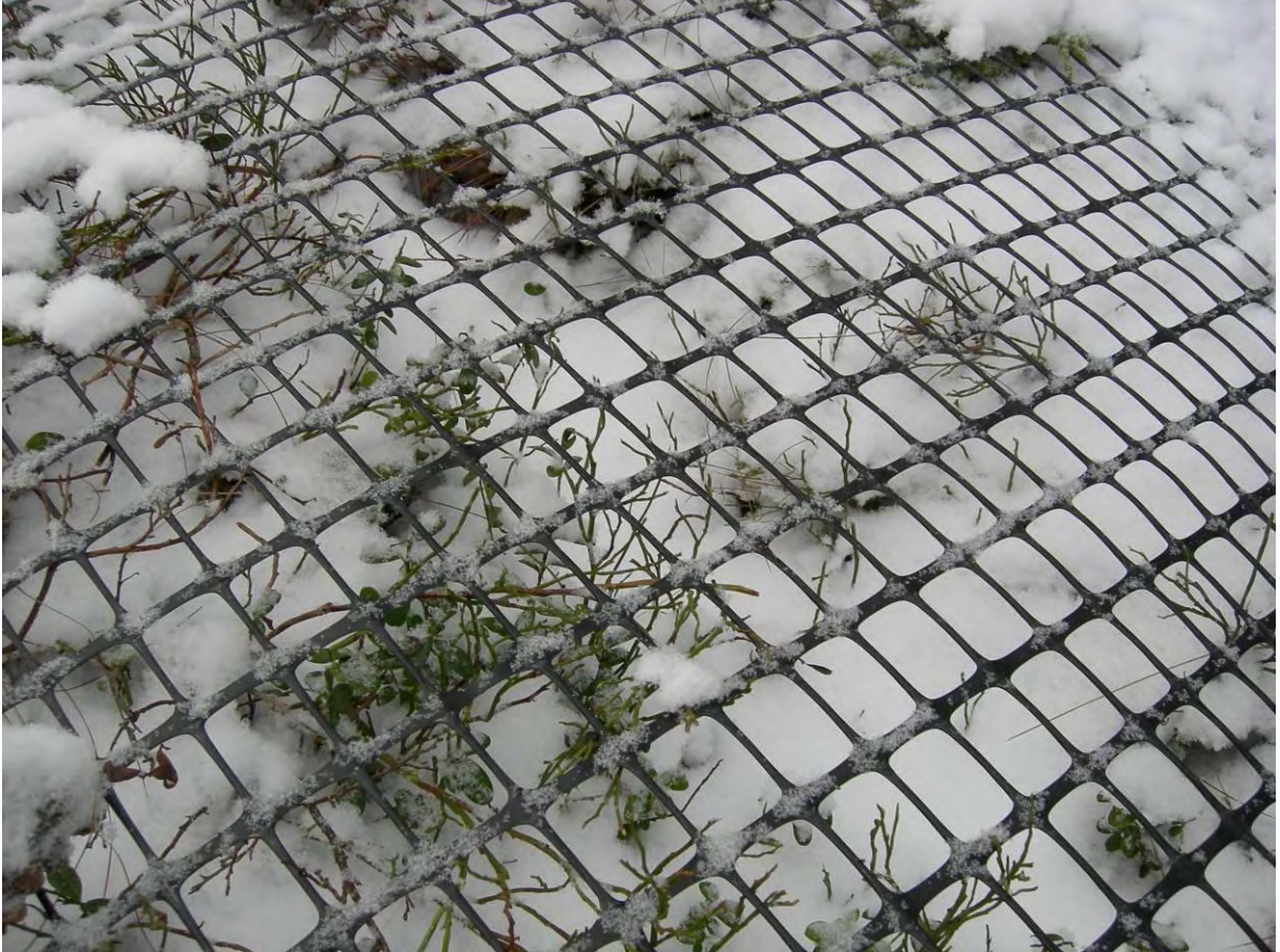
Bilde 10. Geonett før overdekking med kvister/topper. Foto: Anders Eid Hohle. 2010.
