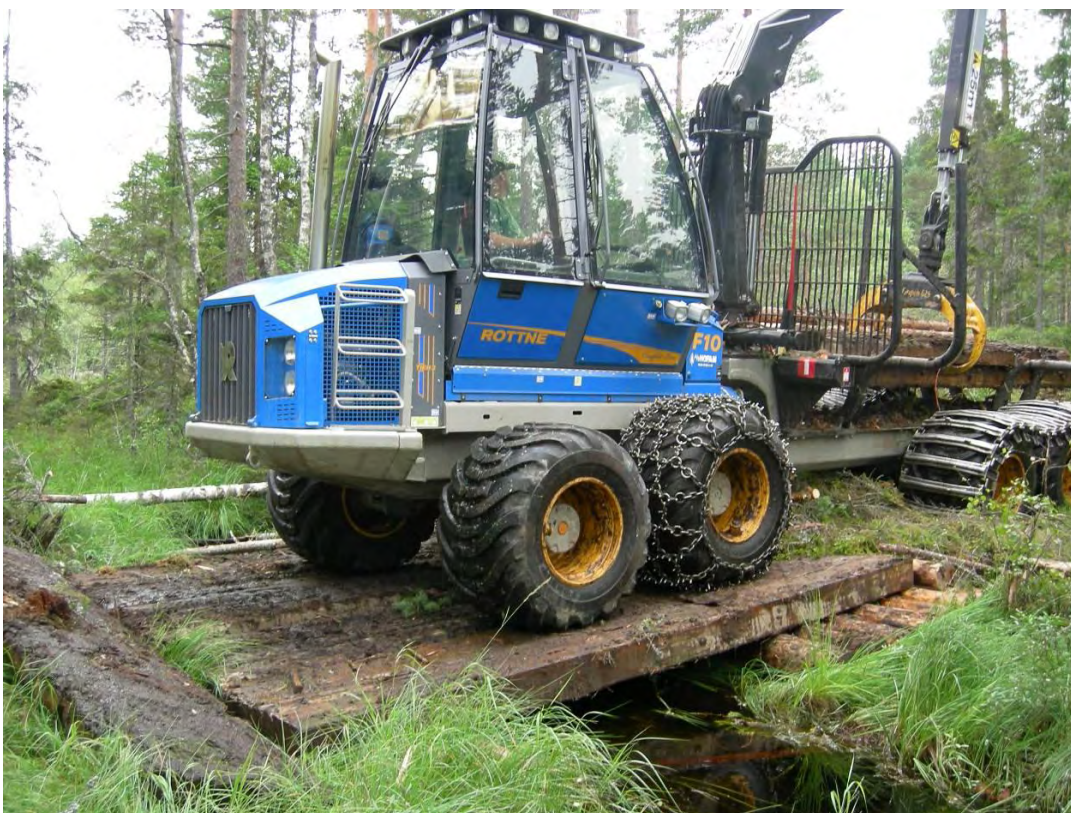
Bilde 9. Bygging av bro over bekk på Fjeldskogen. Foto: Anders Eid Hohle. 2010.
