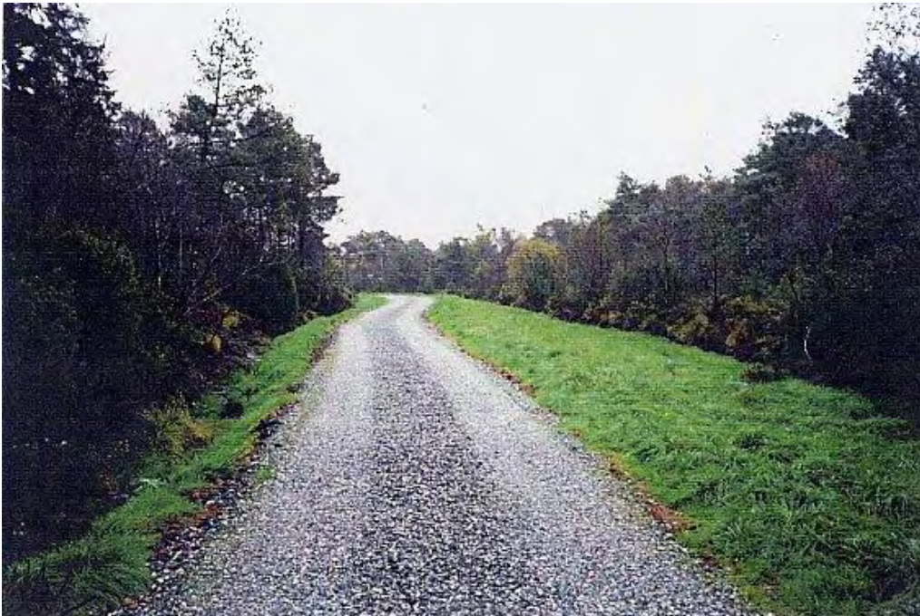
Bilde 14. Flisveg med grovt slitelag. Foto: Gjermund Liereng, 2003.
