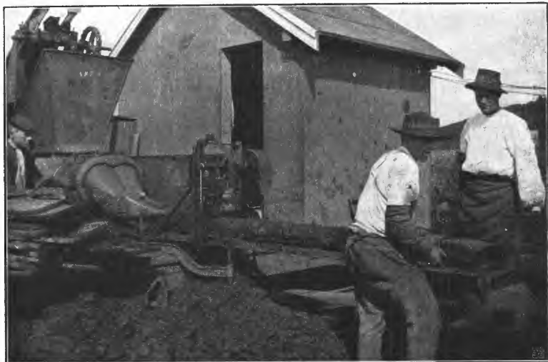
Dolbergs torvmaskine med automatisk afkutningsmekanisme.
