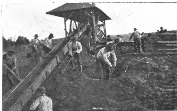
Anreps torvmaskine i arbejde.
