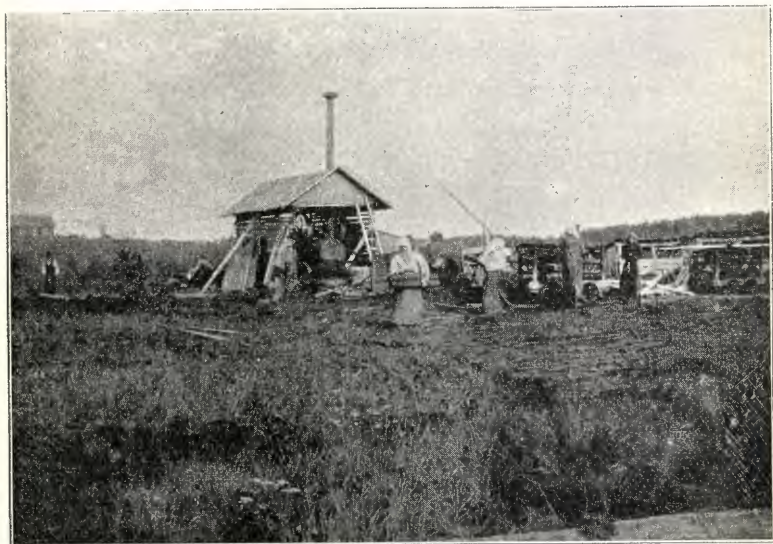
Fig. 3. Stange almennings torvfabrik.
