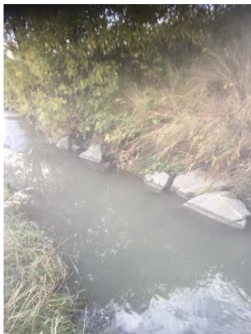
Reparasjon av steinsetting
