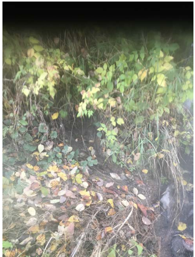
Dreneringsutløpet Foto: Atle
