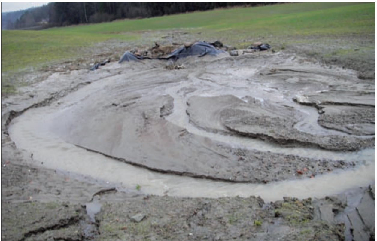
Bilde 3: Kumdam i Frogn etter avrenningsepisode med erosjonsskader på dyrka jord. Foto: Atle Hauge
