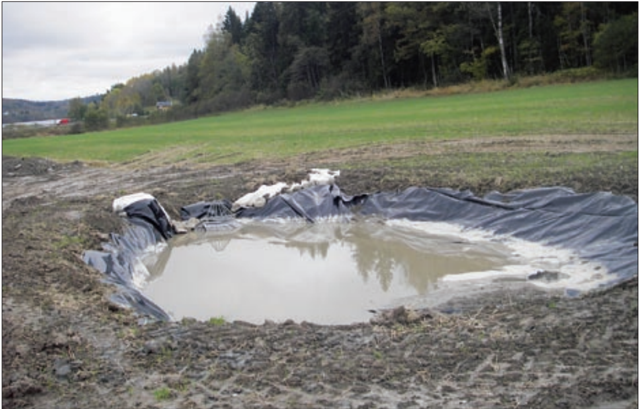
Bilde 2: Kumdam i Frogn like etter at anlegget er ferdig. Kummen er plassert i nedre kant av dammen. Foto: Atle Hauge
