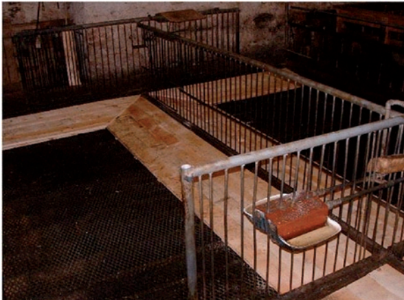
Bilde 1. Eksempel på en liggepall av tre langs veggen i en strekkmetallbinge. Fra Bøe og Nyhammer 2004.
