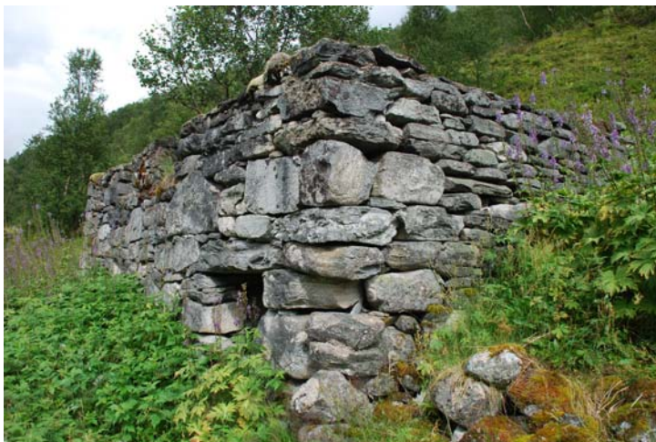
Figur 4.16. Det er formidable dimensjonar på murane etter driftsbygninga. Ein kan framleis sjå spor etter bor i enkelte av dei største steinane, noko som vitnar om at bygget nok stammar frå den seinare tida og at det også da vart satsa på sæterdrift.
