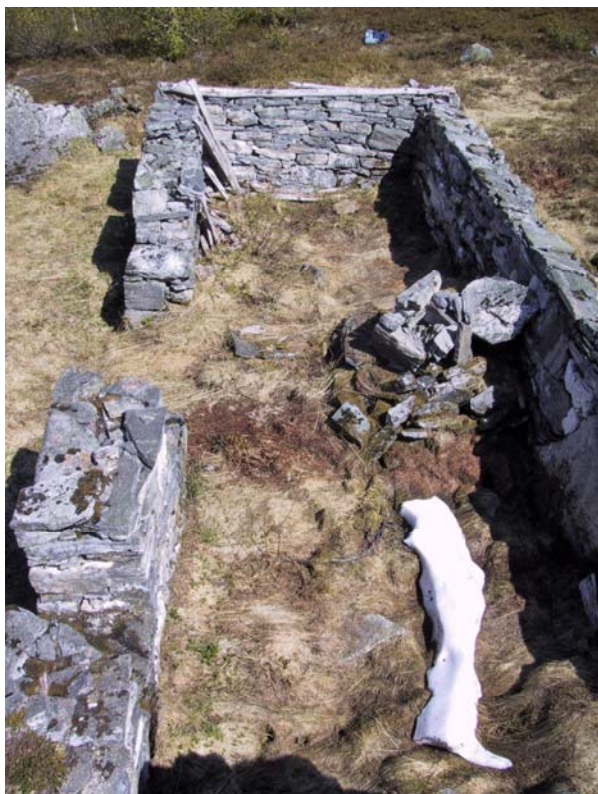
Figur 4.23. Detaljar frå selet på Tverrbakksætra. Sætra ligg i ei blokkmark, i det øvste bildet ser ein korleis bergknausen bak har utgjort den eine gavlveggen. Det store bildet syner murane sett ovafrå og ein ser restane etter den store grua sentralt i rommet. Til høgre ser ein restane av nedste omfar, og ein ser at dimensjonane på virket ein har hatt til rådvelde ikkje er imponerende. Truleg har det her vore nytta virke av lauvtre.
