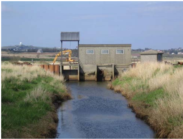
Figur 2. Pumpestasjon i Skas-Heigre kanalen. Foto: J.Deelstra, Bioforsk
