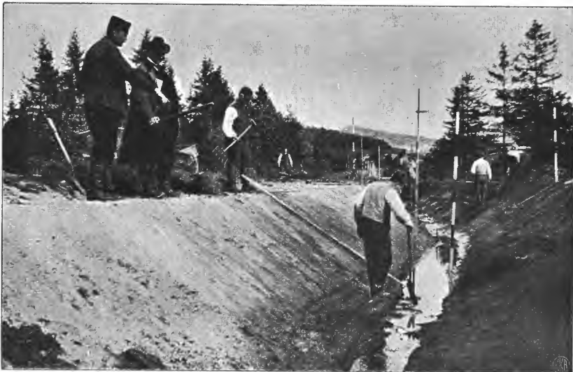
Straffanger under grøftningsarbeider paa statens dyrkningsfelter, Mæresmyren.
