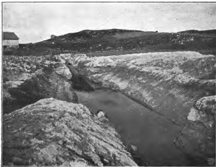
Stokkevandkanalen straks utenfor tunnelmunningen. (Under arbeide).
