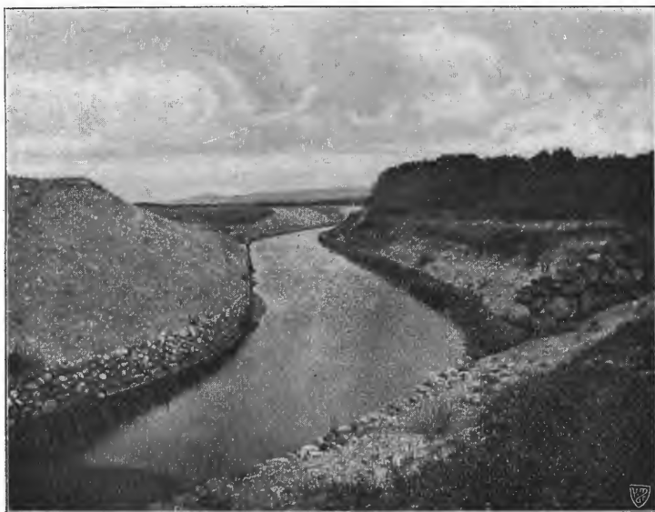
Kanalen fra Høilandsvånd i den største skjæring.
