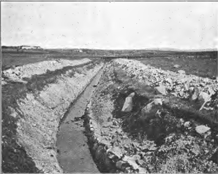
Utgravning av Herikstad- og Auglendsstemmen Time.
