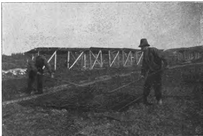
Torvgrøten utjevnes i formrammen
