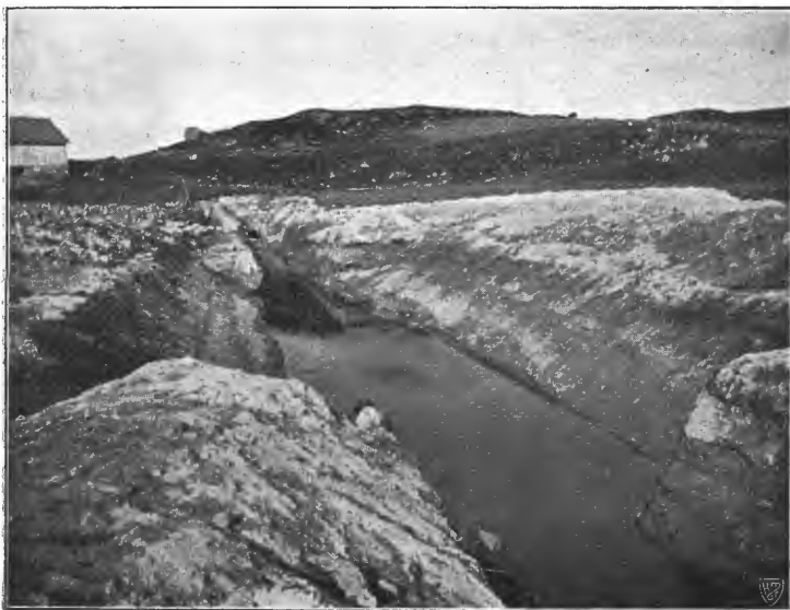
Stokkevandkanalen straks utenfor tunnelmunningen. (Under arbeide).
