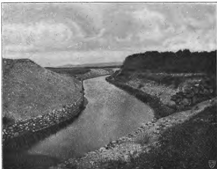
Kanalen fra Høilandsvånd i den største skjæring.
