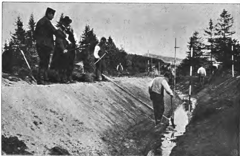
Straffanger under grøftningsarbeider paa statens dyrkningsfelter, Mæresmyren.
