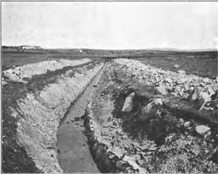
Utgravning av Herikstad- og Auglendsstemmen Time.
