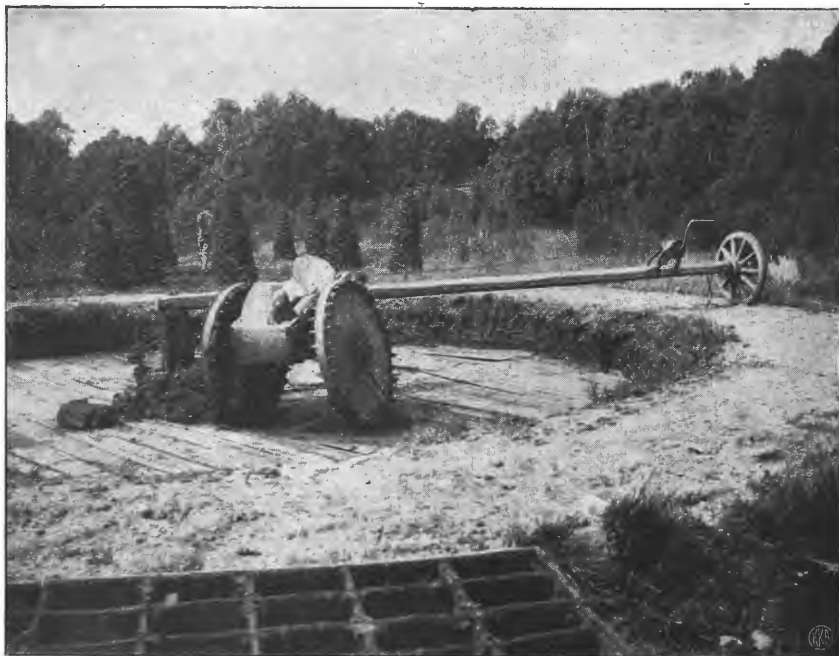
Trampetorvanlæg med hestevandring.
