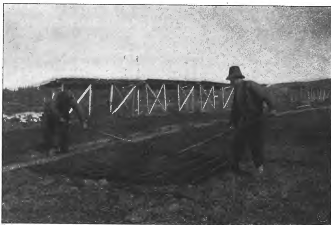
Torvgrøten utjevnes i formrammen.
