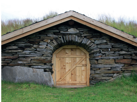
Fjøs med dobbel steinmur og staselig portal over nyrestaurert inngangsdør. Tolga i Hedmark.
