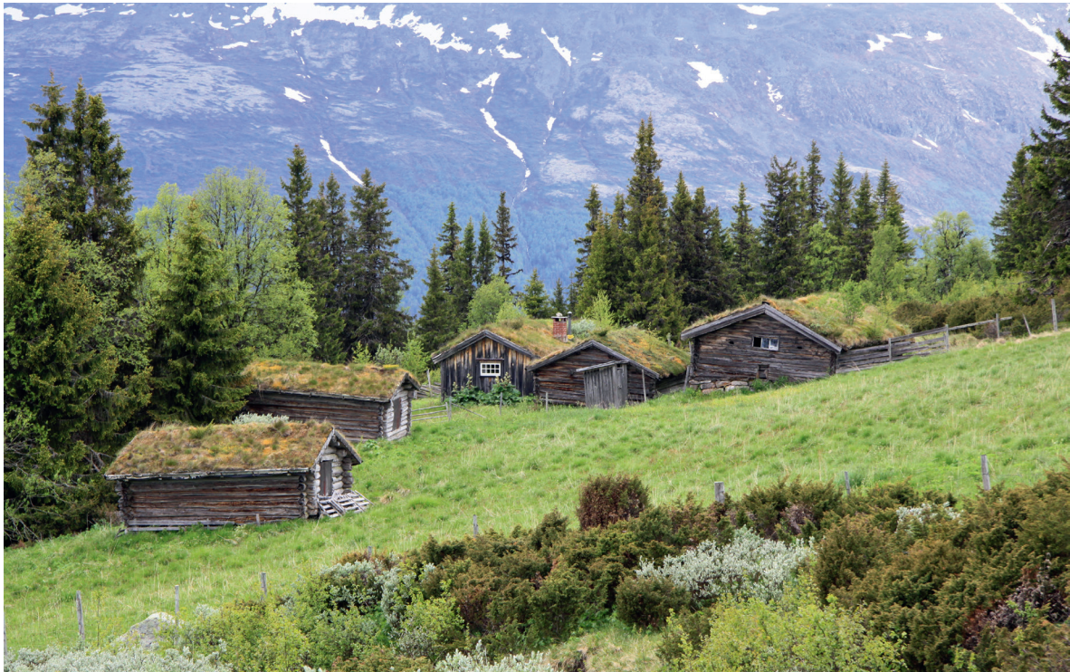
I Østerdalen er tømmer, never og torv viktige komponenter i seterbygningene. Tynset i Hedmark.
