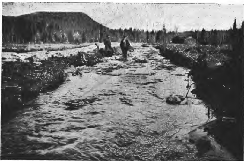
Nytt elveleie, opskutt med 100 gr. ladninger i 2 parallell-grøfter. Den løsskutte masse er spylt vekk.
