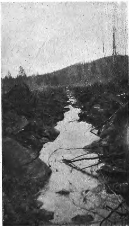
Grøft opskutt med en rekke 100 gr. ladninger.
