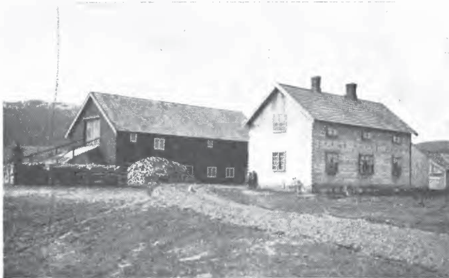
Fig. 4. Even Olsens bureisingsbruk i statsteig A.
