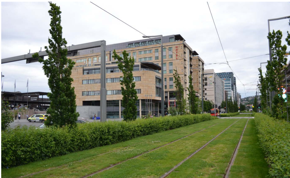
Bilde 13. Grøntanlegget i Dronning Eufemias gate i Oslo er etablert i anleggsjord i henhold til Statens vegvesen (2015)
